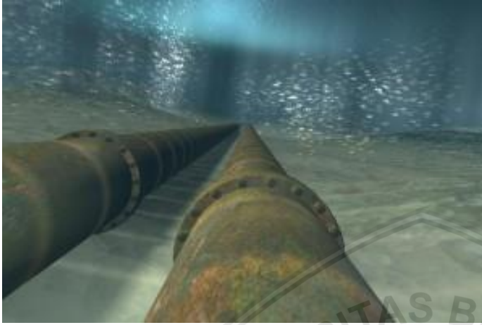
Gambar 2.1 Korosi Pada Pipa Air Laut
