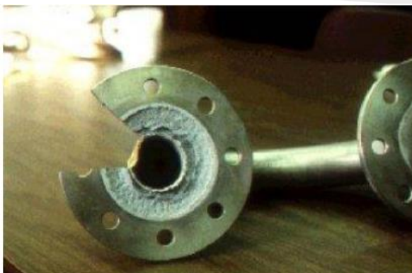
Gambar 2.7 Korosi Celah Sumber : Utomo (2009)
