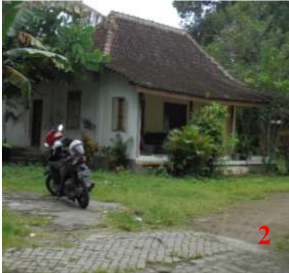
Gambar 4.14 Kondisi bangunan sekitar bagian utara rumah Lantip Kuswala Daya.
