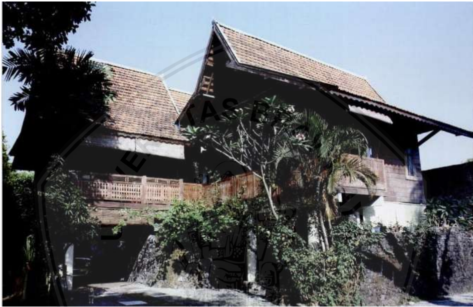
Gambar 4.28 Fasad bangunan rumah Lantip Kuswala Daya.
