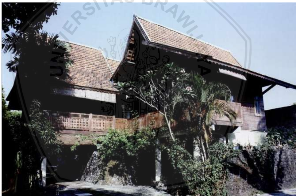
Gambar 2.23 Fasad bangunan rumah Lantip Kuswala Daya.
