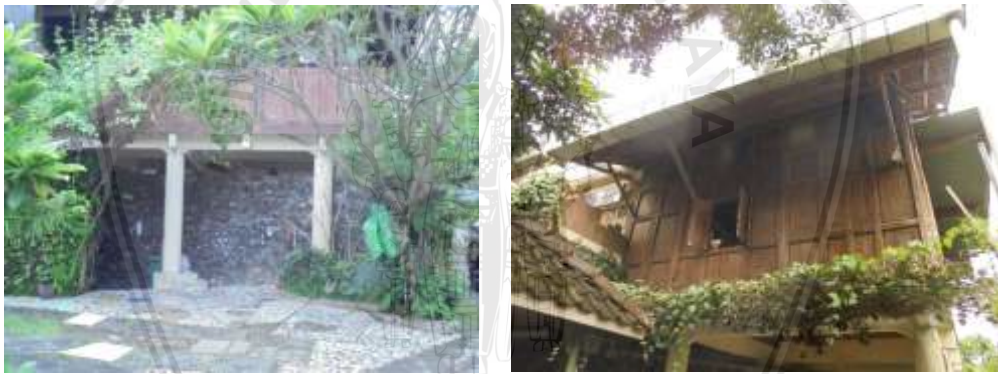
Gambar 4.44 Dinding batu alam dan dinding kayu rumah Lantip Kuswala Daya.
