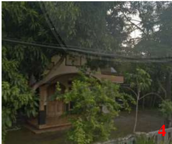
Gambar 4.16 Kondisi bangunan sekitar barat daya rumah Lantip Kuswala Daya.
