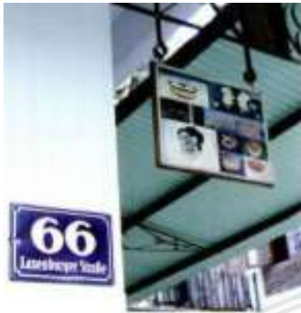
Gambar 4.38 Penyangga tritisan besi rumah Djaduk Ferianto.
