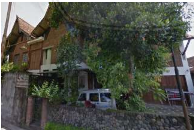
Gambar 4.20 Fasad bangunan rumah Djuduk Ferianto bagian timur.
