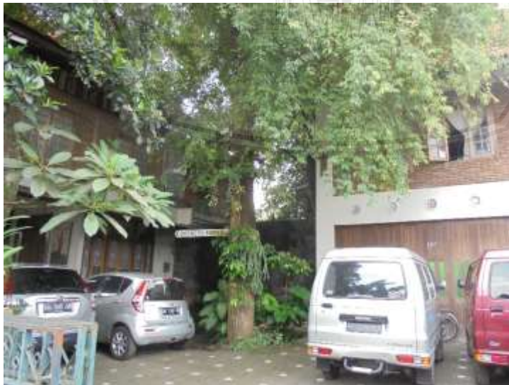
Gambar 4.41 Kondisi tapak rumah Djaduk Ferianto.
