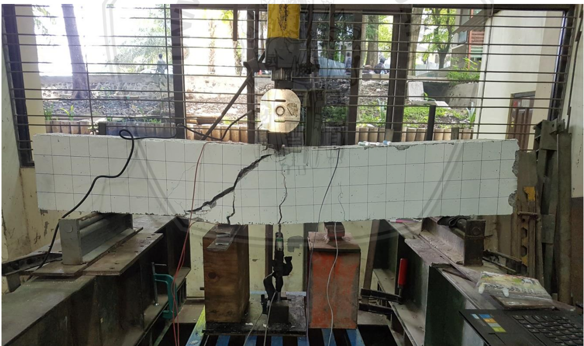
Gambar 10. Kondisi balok N2 (2) setelah pengujian dengan beban maksimum 4100 kg
