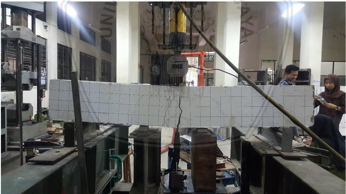
Gambar 6. Kondisi balok N1 setelah pengujian dengan beban maksimum 4500 kg
