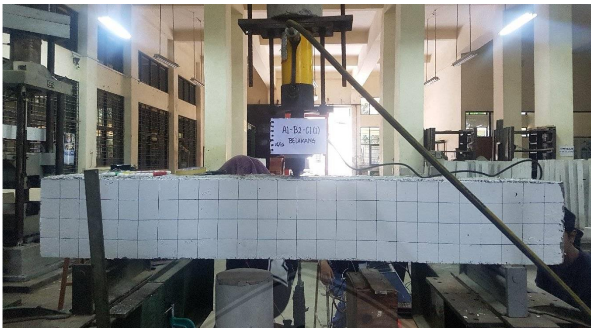
Gambar 15. Kondisi balok A1-B2-C1 (1) sebelum pengujian (Diuji 16 Desember 2018)
