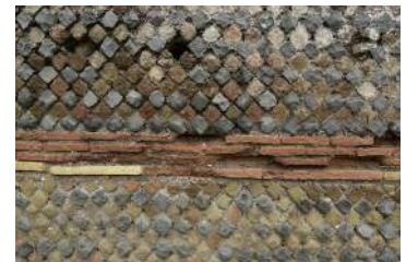
Foto de Juan Sixto López. Detalle de pared construida con el método opus reticulatum .
