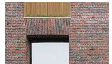
Detalle de los arcos planos sobre las aberturas de cada nivel.
