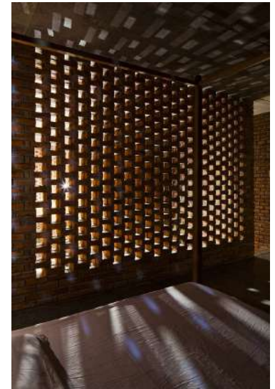
Celosía de ladrillo, que tamiza la luz y deja pasar la brisa.
