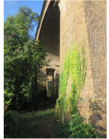
Foto de Laurie Lopes. El viaducto ferroviario de Wharncliffe, 1836, es un ejemplo del uso del ladrillo en las nuevas infraestructuras.
