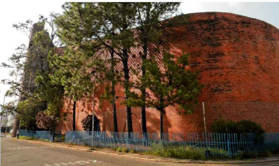
Foto del muro exterior de la iglesia.
