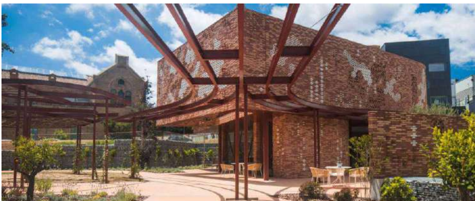
Fachada posterior del centro Kálida, desde el patio privado.
