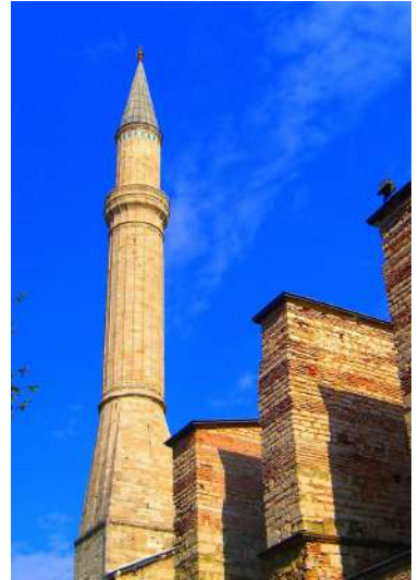
Foto de Donatoneruben. Detalle de los contrafuertes de la actual Mezquita de Santa Sofía, la mayoría de la obra está recubierta por un acabado, y sólo en algunas zonas es visible el ladrillo.
