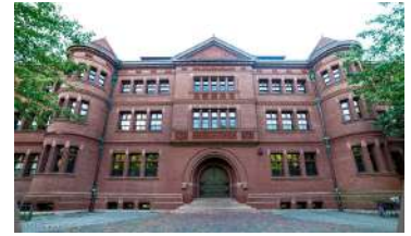
Foto de Ken Zirkel. Sever Hall (1878-1880). Universidad de Harvard, Cambridge, Massachusetts, EEUU. La fachada está realzada en algunas zonas con ladrillos cortados y moldeados.
