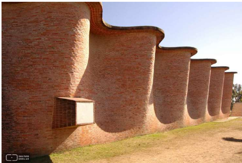
Fachada lateral donde se puede apreciar los conoides.
