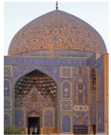
Foto de Sebastià Giralt. Mezquita de Luffullah (1603-1619), Ispahán, Irán. Construida a un lado de la maidan, el portal de entrada exhibe una exquisita bóveda de mocárabes.
