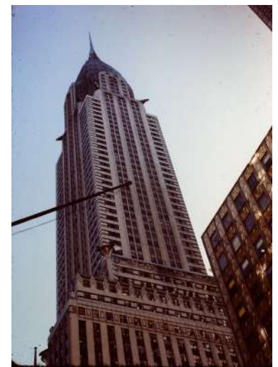
Foto de Martin Beek. Edificio Chrysler, Nueva York, EEUU (1928-1931), el rascacielos está recubierto en su totalidad con ladrillos esmaltados.
