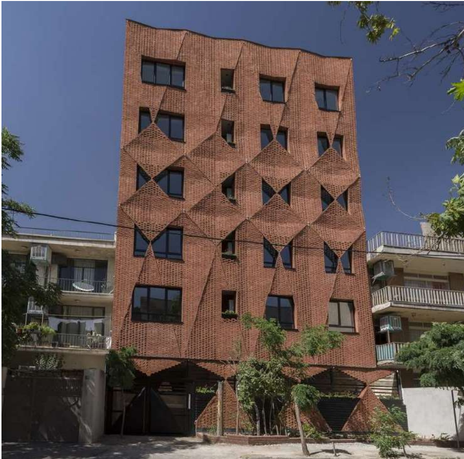
Fachada principal de la casa de Ladrillo.
