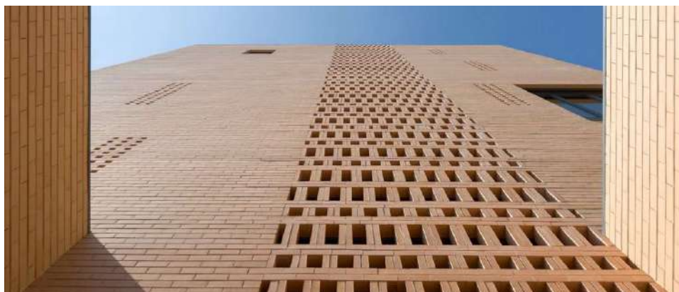
Detalle de la celosía que cubre las ventanas de la escalera.
