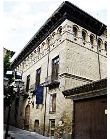
Foto de Pedro Pablo García. Casa de Miguel Donlope, Zaragoza, (siglo XVI), fachada de ladrillo con el acabado típico aragonés.
