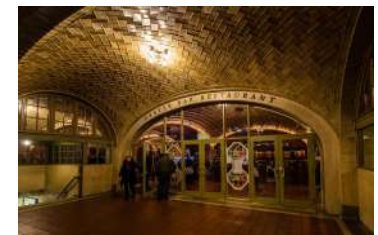
Foto de Paul. El Oyster Bar de Grand Central Station, Nueva York, EEUU. Construido en 1871 un ejemplo del uso de la cúpula de Rafael Guastavino.
