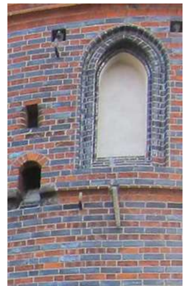
Foto de Alexi Malutin. Puerta de Holstein, Lübeck (1477), cuenta con ladrillos vidriados y paneles de terracota alrededor de las las ventanas.
