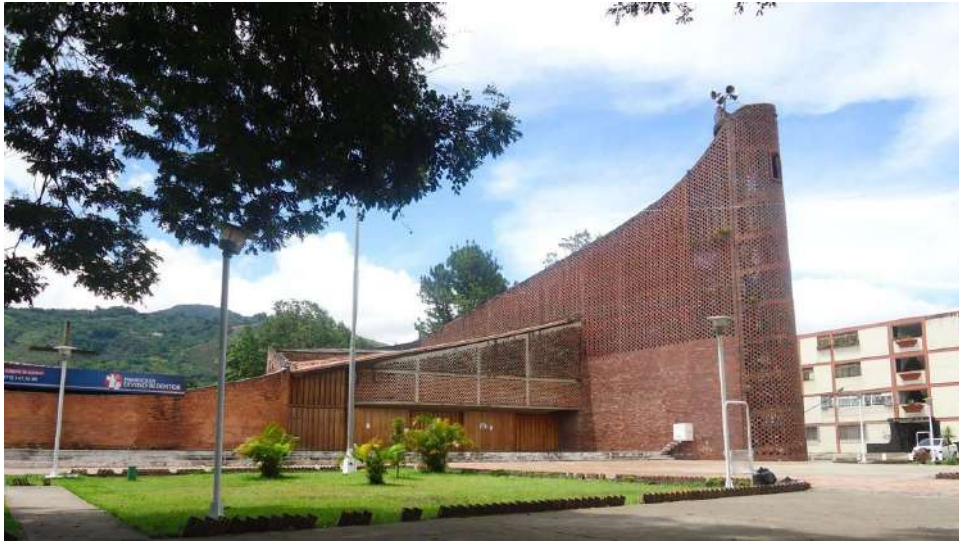
Fachada principal de la Iglesia Divino Redentor.
