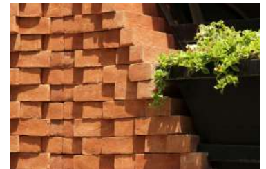
Detalle de la colocación de ladrillos.
