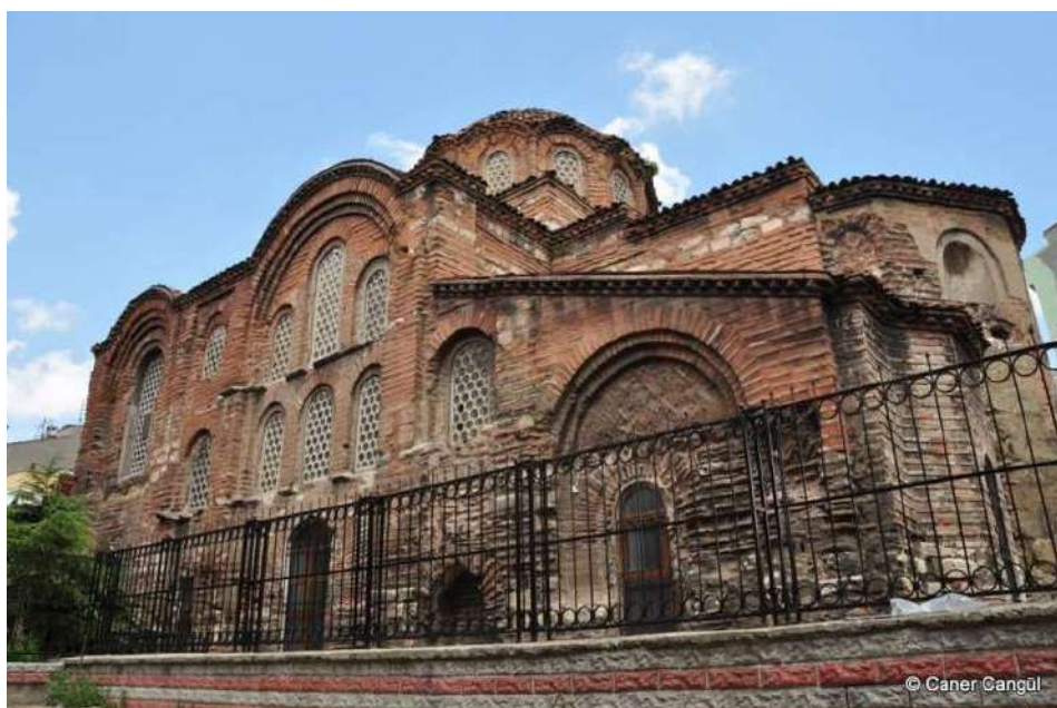
Foto de Caner Cangul. Iglesia de Cristo Pantepoptes, Estambul, construida en el año 1080. Las espaciadas hiladas de ladrillos se colocaron utilizando la técnica del ladrillo empotrado.
