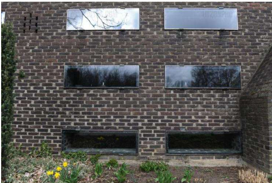
Fachada de la sala de reuniones. Lewerentz diseñó un pequeño complejo compuesto para la iglesia, una sala de reuniones y oficinas, recogido con junto para el que se accede a la iglesia.
