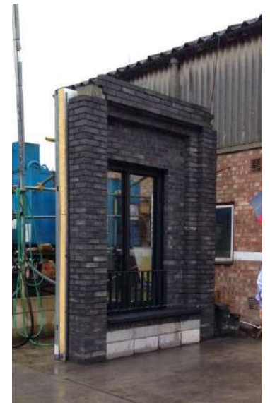
Prueba constructiva de la fachada de ladrillo a escala real.
