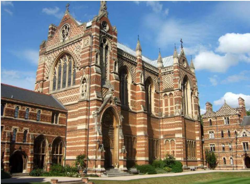
Foto de Rex Harris. Capilla del Keble College. Oxford (1867-1883). Ejemplo de neogótico donde se usó diferentes ladrillos de colores, azules de Staffordshire, amarillos de Londres y rojos de Kentish.
