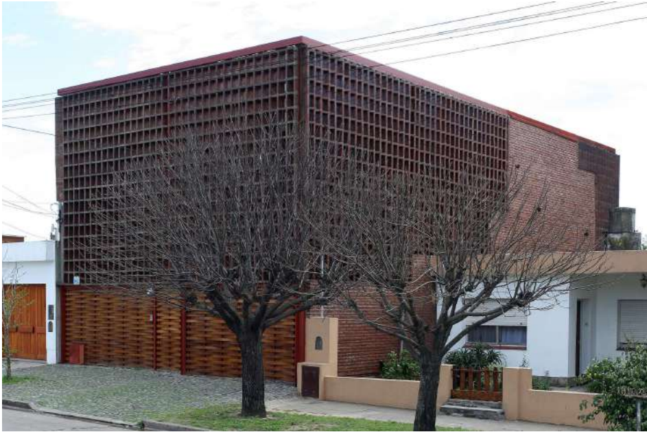
Fachada principal de la casa de los tamices.
