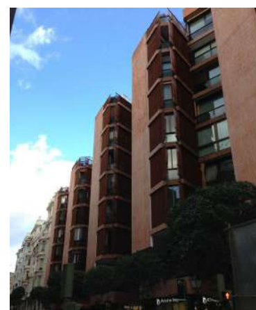
Fachada del edificio girasol desde la calle Lagasca.
