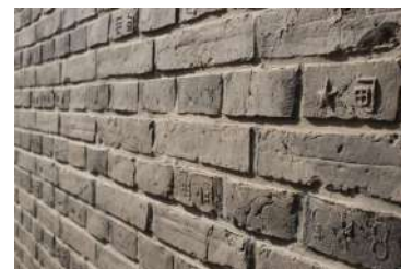
Foto de Maahwish. Detalles de los ladrillos de la Gran Muralla, donde se pueden ver las marcas hechas por su fabricantes.
