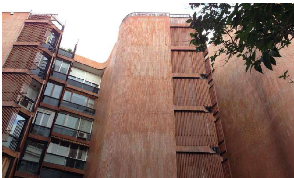
Fachada donde se puede ver el recubrimiento de ladrillo y las oberturas de techo a suelo protegidas por celosías de madera.
