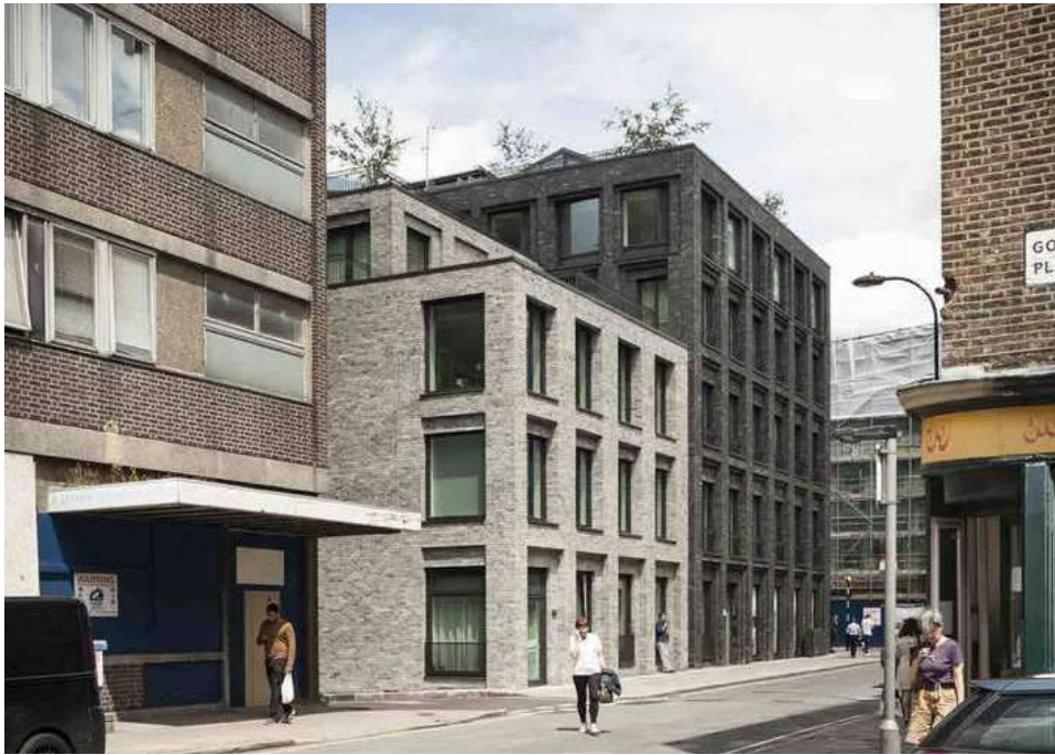
Vista de las fachada desde la calle Tottenham Street.
