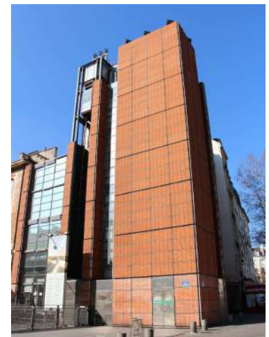
Foto de Fred Romero. Anexo del IRCAM, París, Francia (1988-1989), se utilizaron ladrillo perforados, dentro de un entramado metálico que actúa como cerramiento de las escaleras y el ascensor.
