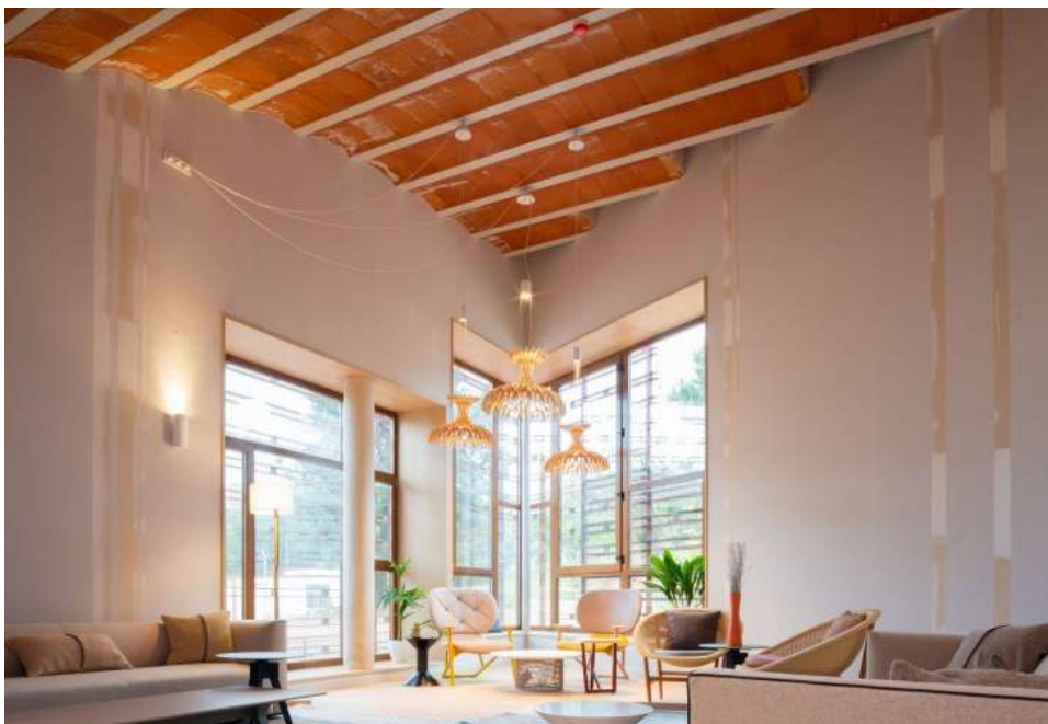
Interior del centro Kálida, donde se puede ver las bovedillas cerámicas.
