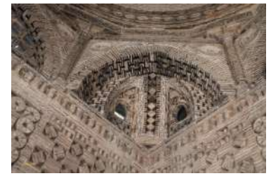
Foto de Francois Canto. Detalle del arco de pechina que soporta la cúpula.
