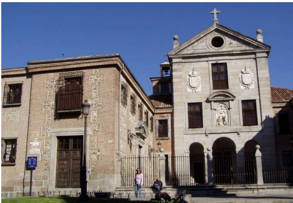
Foto de Dan. Real Monasterio de la Encarnación, Madrid (1616). Edificio de ladrillo usando el método de opus mixtum.
