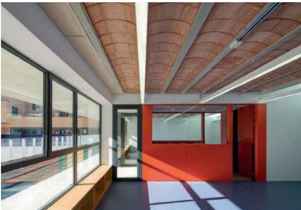
Interior una de las aulas, donde se puede apreciar la bovedilla cerámica.
