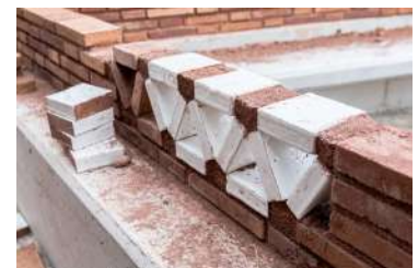
Detalle de la colocación de los ladrillos, para construir la celosías.
