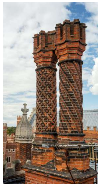
Foto de Karli Watson. Ejemplo de chimenea en espiral de la torre de Layer Marney, creada con ladrillos modelados.
