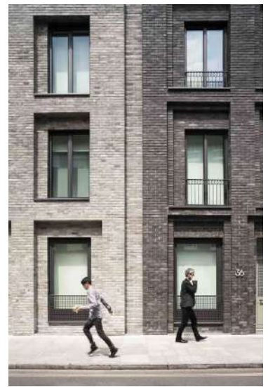
Detalle de la fachada, donde se diferencia los dos colores de ladrillo utilizado.
