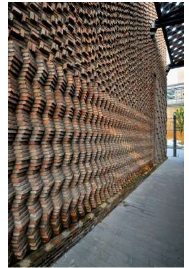
Detalles de los diferentes aparejos de ladrillo utilizados en la fachada.
