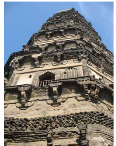
Foto de William Hsu. Pagoda de Yunyansi (929 a. C.), Suzhou, posee 47,7 m de altura con soportes de ladrillo imitando a la madera.
