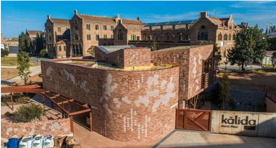
Fachada principal del centro Kálida Sant Pau.
