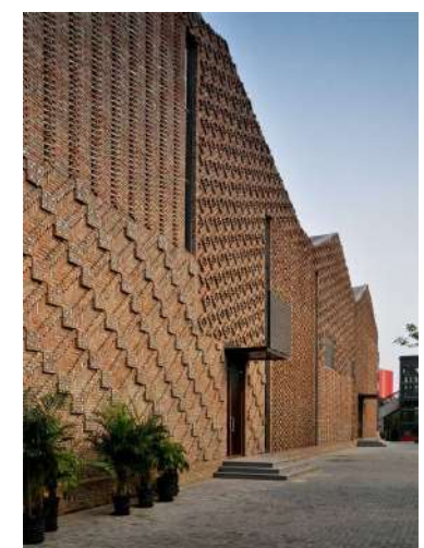
Fachada de ladrillo intercalando los diferentes diseños.
