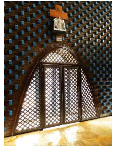
Detalle del muro interior con una de sus puertas con celosía, donde se puede ver el ladrillo anteriormente vitrificado de color azul, pintado ahora de un azul intenso.
