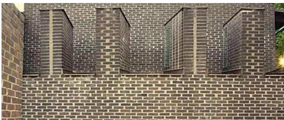
Lucernarios que iluminan la sacristía de la iglesia.
