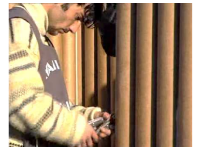
Fig 74. Voluntario colocando el adhesivo. Paper Log House, Kobe, 1995.
