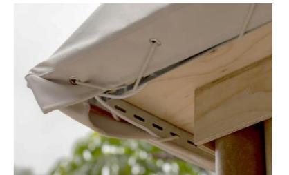
Fig 76. Sujeción de cubierta. Paper Log House, Kobe, 1995.
