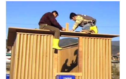
Fig 75. Colocación de un panel de madera. Paper Log House, Kobe, 1995..
