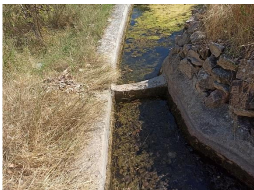
Fig. 76: Entrada de agua a la balsa de la Cestera 2 (Tomo II, R05).
