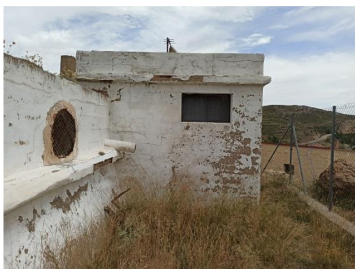
Fig. 64: Deposito Viejo del pueblo.
