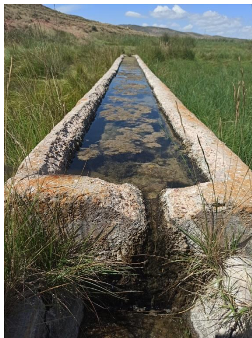
Fig. 69: Pila de hormigón del Abrevadero de la Macheta (Tomo II, AB3).
