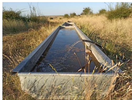
Fig. 68: Pila metálica del Abrevadero de Carrasegura (Tomo II, F05).
