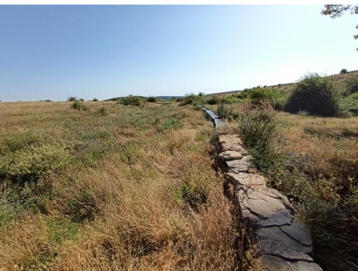
Fig. 42: Muro de conducción del Cañuelo (F07).
