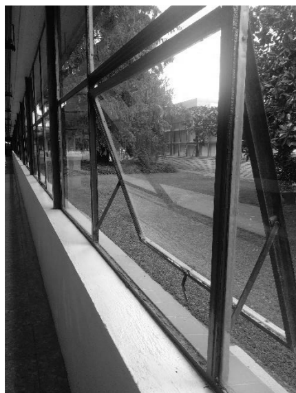
Intervención en pasillos
