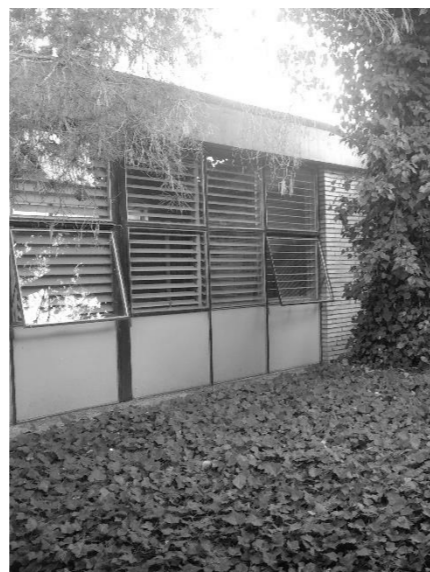
Intervención en aulas manteniendo carpintería original (quitando vidrio)
