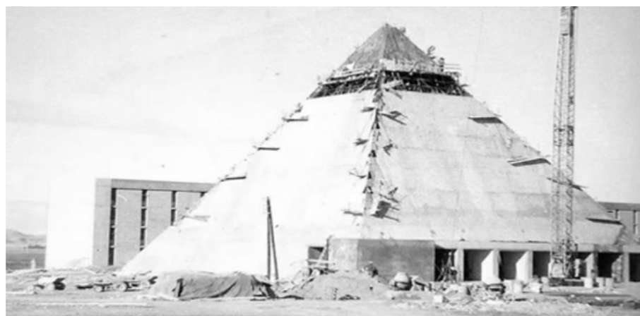
Proceso de construcción de la Pirámide
