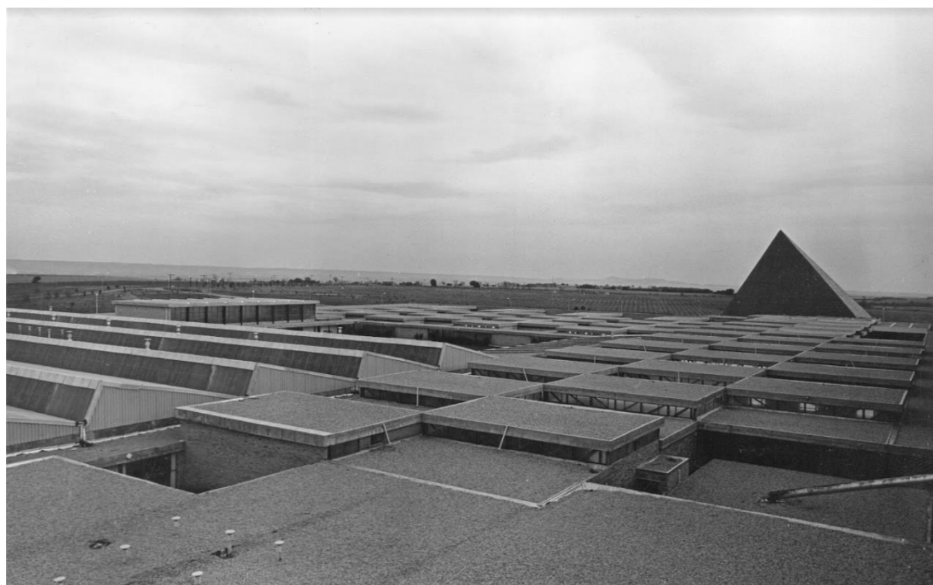
Universidad Laboral de Huesca Vista desde la cubierta. El módulo
