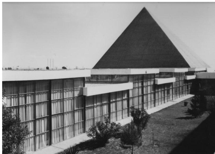
Vista de los patios con carpinterías originales.
