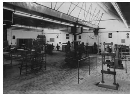
Imagen interior de talleres
