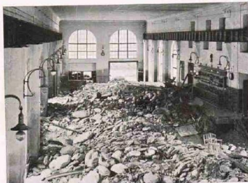
Fig. 13. — La sala de màquines de la Central de Capdella, després dels aiguats d'octubre del 1937.
