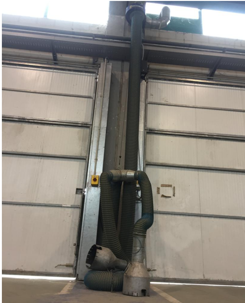
Fig. 11 Extractores de humo actuales para Leopard 2E
