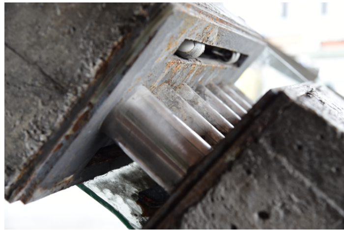
Figura 6 Detalle de los redondos de las articulaciones
