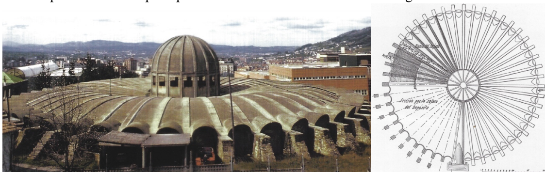
Figuras 45 (a) y (b) IV Depósito de Oviedo en la actualidad; Plano en planta del IV Depósito
