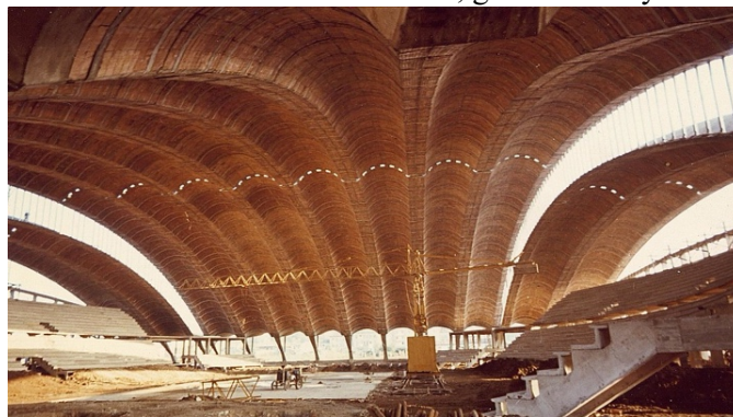
Figura 3 Vista interior del Palacio de los Deportes
