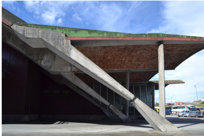
Figura 5 Contrafuertes, articulaciones y vuelos laterales
