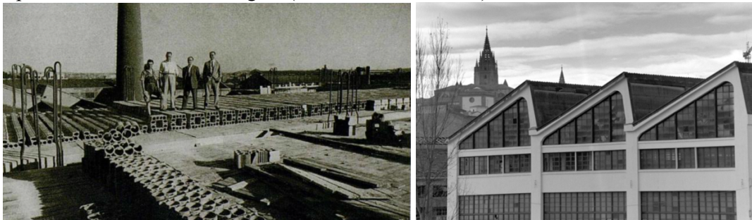
Figura 52 (a) y (b) Fabricación de piezas cerámicas en Río-Cerámica; fachada de la Fábrica de Armas de Oviedo
