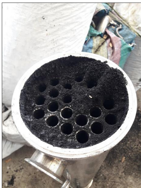
Figura 18: Limpieza tubería. Fuente propia
