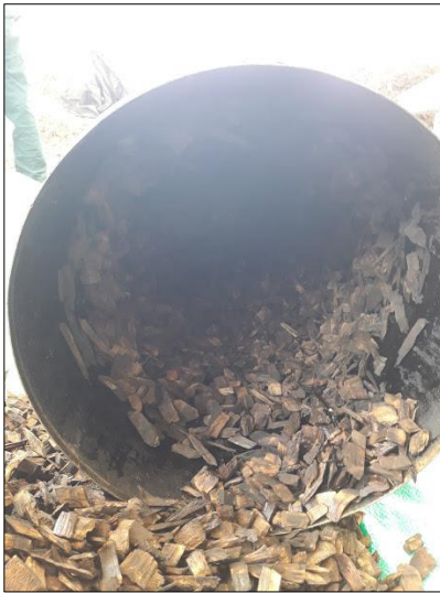
Figura 25: Retiro de filtro existente. Fuente propia
