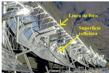
Figura 1. Concentradores cilindros parabólicos.
