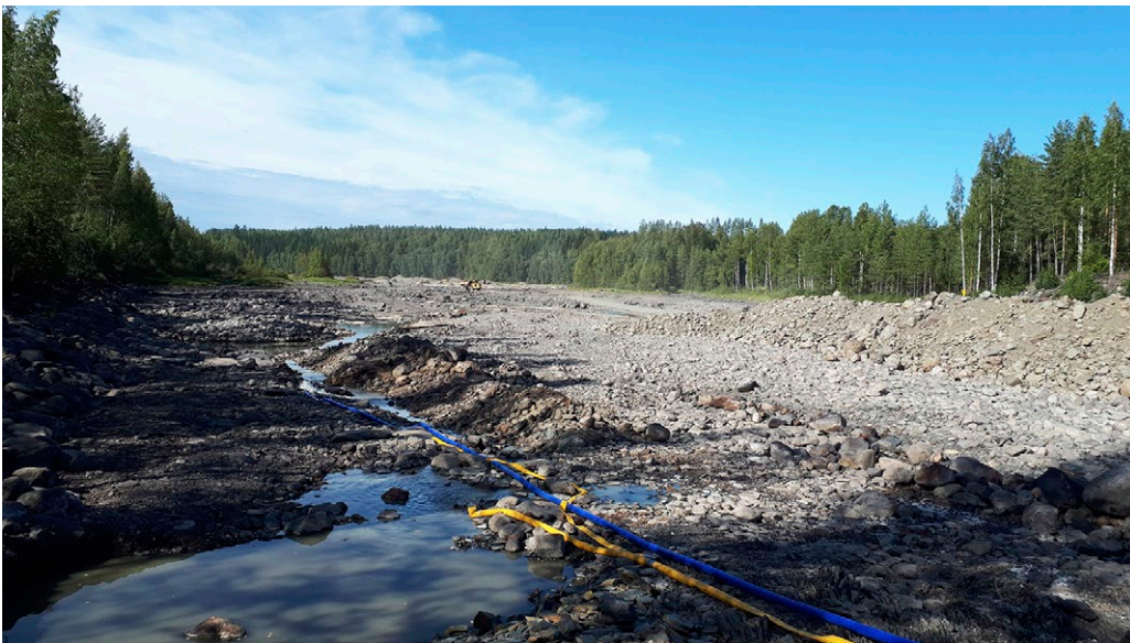
Vesivoiman haittoja voidaan vähentää rakentamalla uusia virtavesielinympäristöjä voimalaitoksen yhteyteen. Kuvassa Pielisjoen Kuurnan voimalaitoksen vanhaan uomaan vuonna 2019 rakennettu järvilohen lisääntymis- ja poikasalue ennen vesittämistä. Kuva: Saija Koljonen.
