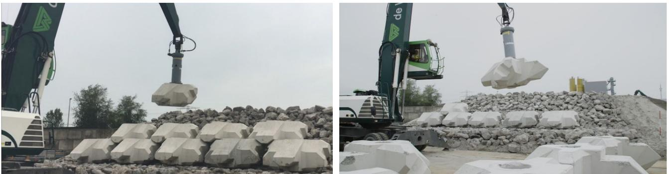
Fig. 12. Placement of 2.5 m<sup>3</sup> XblocPlus
