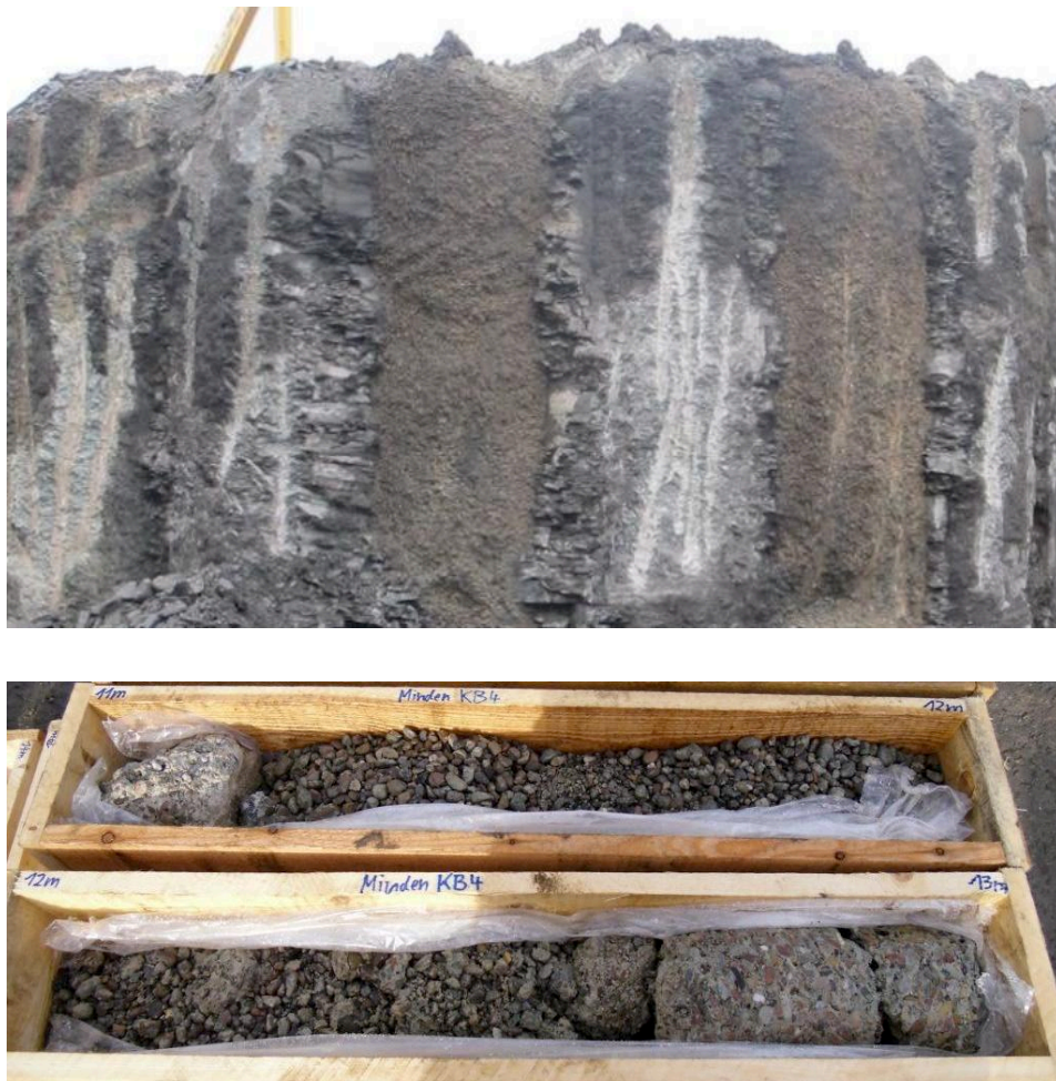
Bild 2: Großversuch mit Primärpfählen aus Dränbeton und Sekundärpfählen aus üblichem zementgesättigten Beton und zugehöriger Bohrkern (entmischter Kies im oberen Bereich, dichter Zementstein im unteren Bereich)
