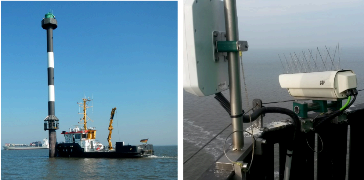
Bild 11 Aufbau des Kamerasystems am Unterfeuer Wremerloch (Herrling und Winter 2017a).
