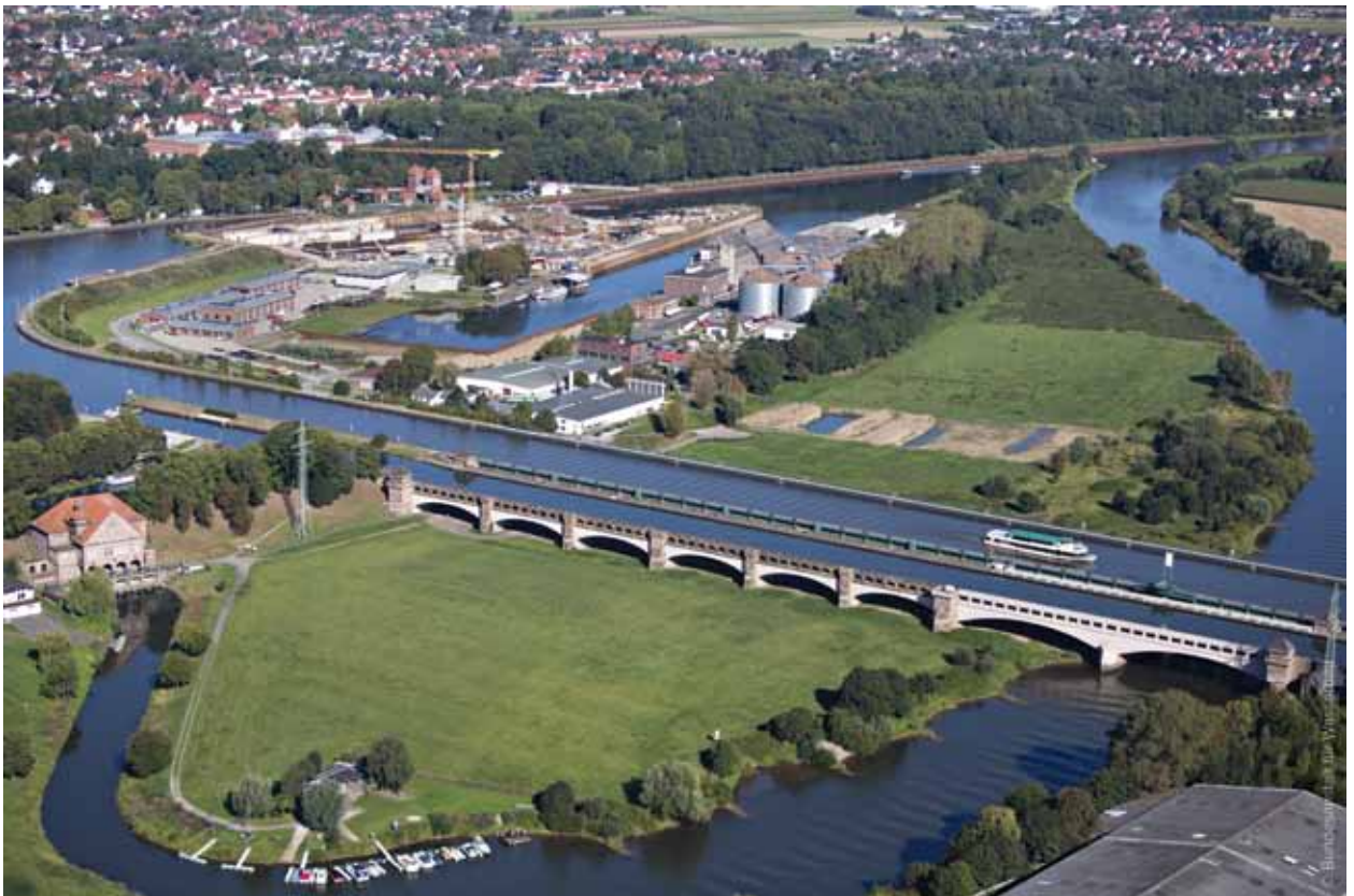
Bau der Weserschleuse Minden
