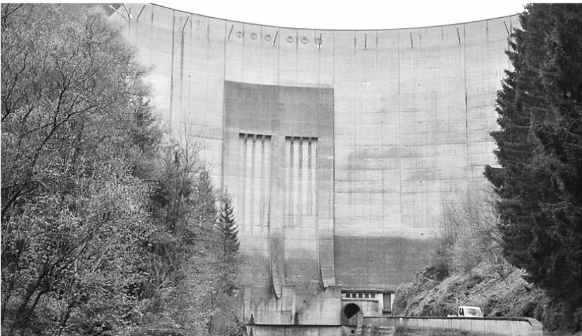
**Abbildung 1:** Luftseitige Ansicht der einfach gekrümmten Bogenmauer der Okertalsperre
