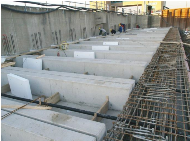
Abbildung 8 Schleuse Eibach: Baustellenfoto mit oberer Rahmenkonstruktion und Kopf der Bohrpfahlwand
