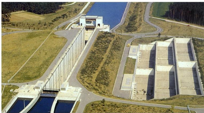
Abbildung 1: Typische Schleuse mit seitlichen Sparbecken am Main-Donau-Kanal
