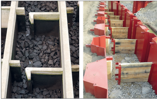
Bild 1: Trockengelegter Schlitzpass mit rauher Sohle und Betonwand an der Stauanlage Koblenz/Mosel (links); Spundwand als Wandelement eines Schlitzpasses (rechts; Quelle: D. Schmidt, team ferox GmbH, Dresden)
