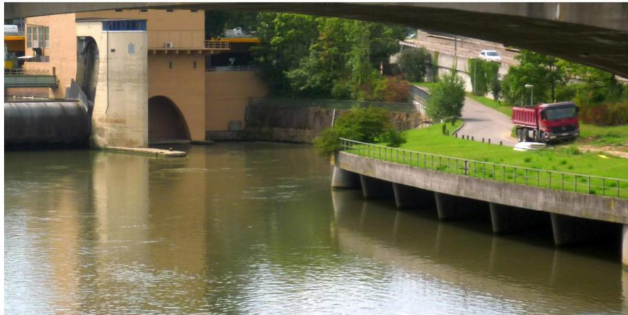
Bild 7: Einleitungsbauwerk des Mischwassersammlers Nesenbach im Unterwasser der Neckarstausthaltung Cannstatt (Quelle: BAW/Belzner)
