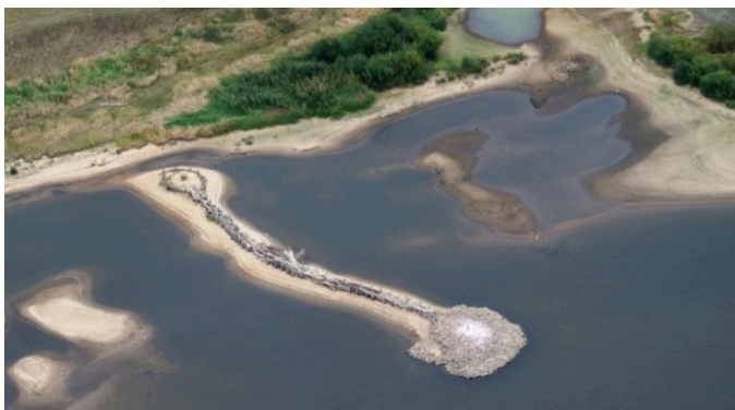
Bild 3: links: Totholzbühne an der Mittel- und Oberelbe (WSA Magdeburg) rechts: zur Sicherung vor Eisangriff überschüttete Totholzbühne an der Mittel- und Oberelbe (BAW)
