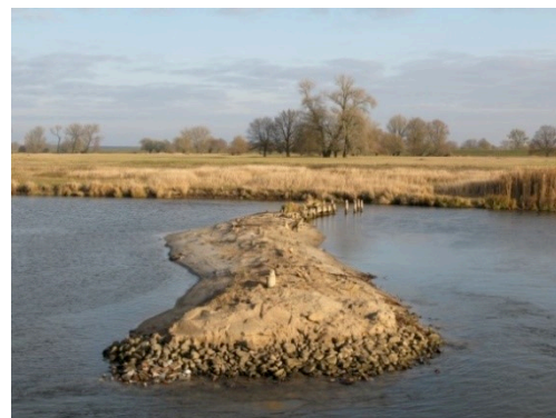
Bild 3: links: Totholzbühne an der Mittel- und Oberelbe (WSA Magdeburg) rechts: zur Sicherung vor Eisangriff überschüttete Totholzbühne an der Mittel- und Oberelbe (BAW)
