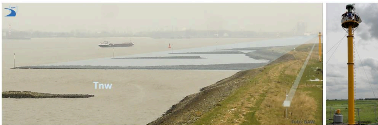
Bild 12: Teil der Messinfrastruktur zur Erfassung der zeitlich und räumlichen Schadensentwicklung der Strombuhne BN31 mit Pfahl und autarker Messplattform sowie Messprinzip bei Tnw inkl. Einmessung zu Fixpunkten (schematisch; nach Uliczka 2015)
