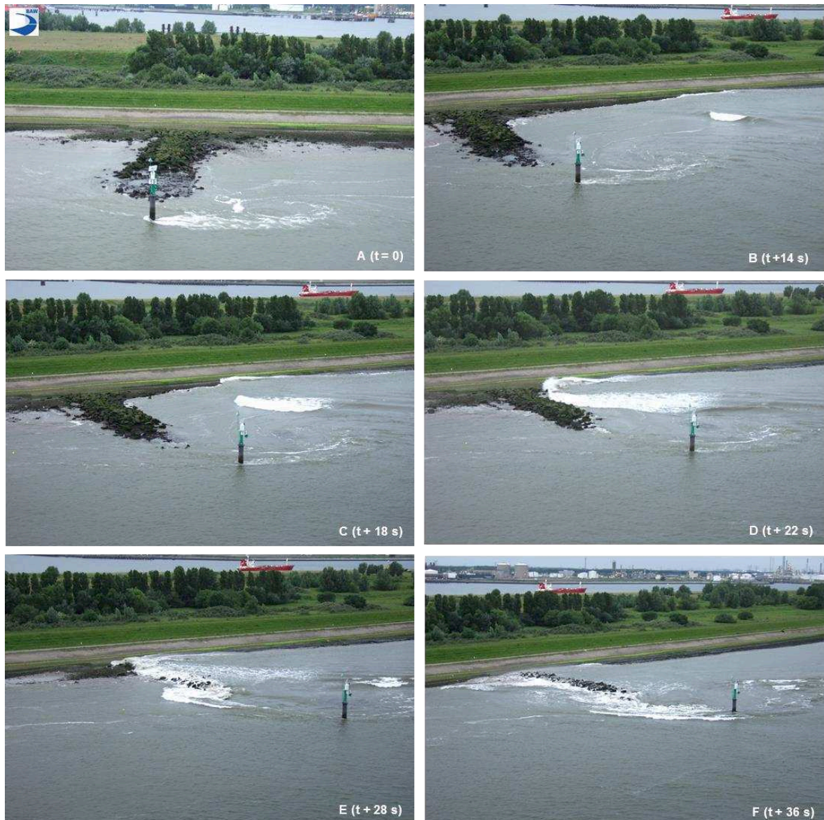
Bild 1: Zeitliche Abfolge der Belastung von Deckwerk und Strombuhne an einer engen Seeschiffahrtsstraße bei Passage eines PPM-Containerschiffs mit etwa v_{\text{Saw}} \approx 13 \text{ kn} (Fotos: BAW 2004; aus BAW 2011)
