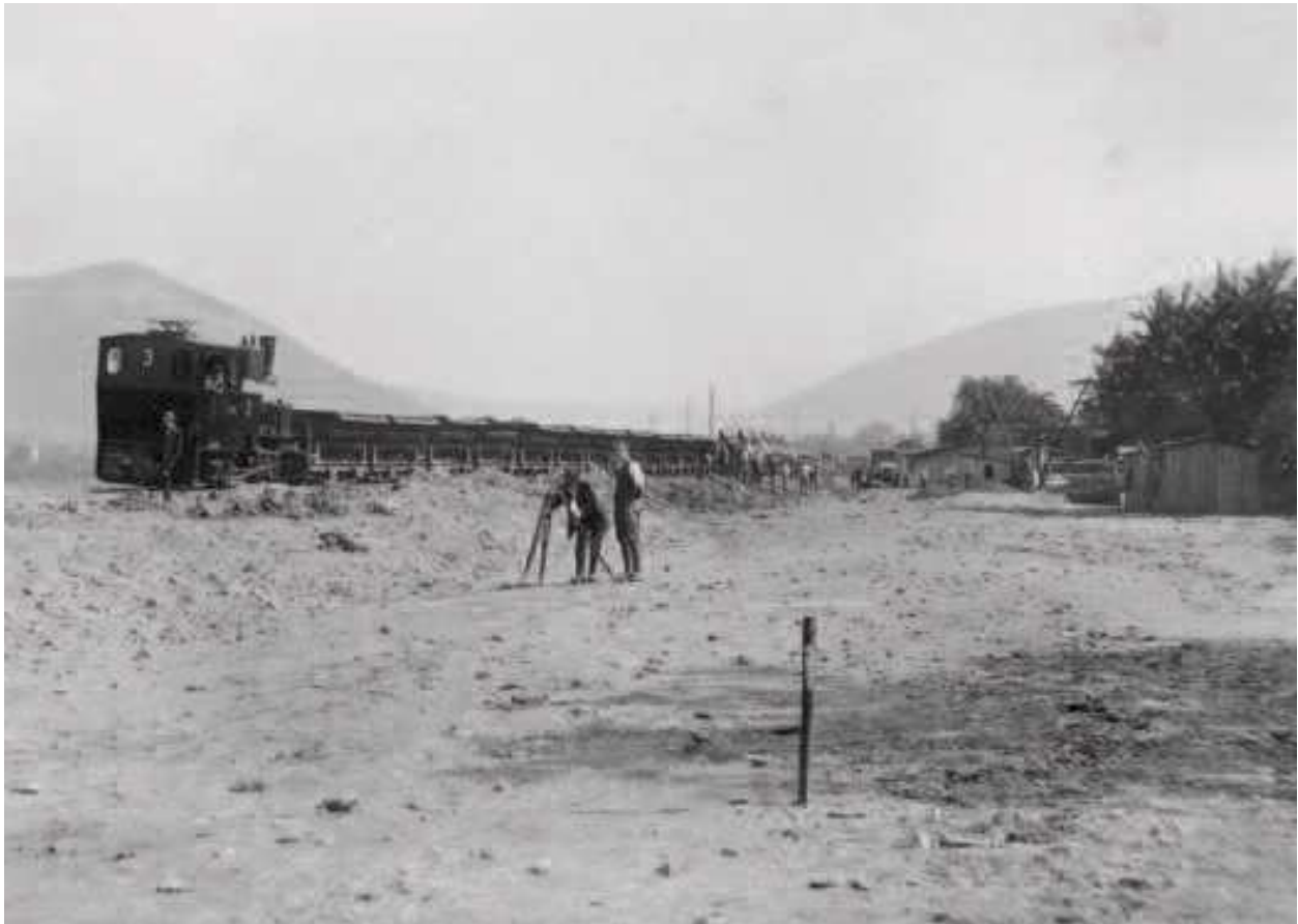
Abbildung 15 | Vermessung des Baugebietes für das Wehr Wieblingen am Neckar, September 1922 Quelle: Bundesanstalt für Wasserbau, HB 1895
