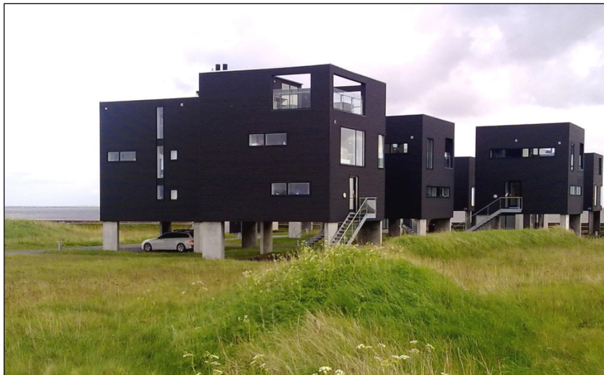
Abbildung 5: „Häuser auf Stelzen“ auf der Insel Røm (DK) als Beispiel für hochwasserangepasstes Bauen in überflutungsgefährdeten Küstenniederungen (MELUND).
