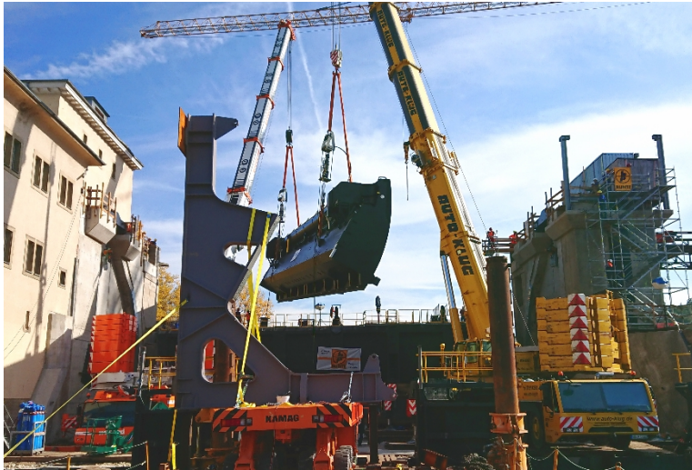
Abbildung 9: Montage vor Ort (Quelle: IRS AG)
