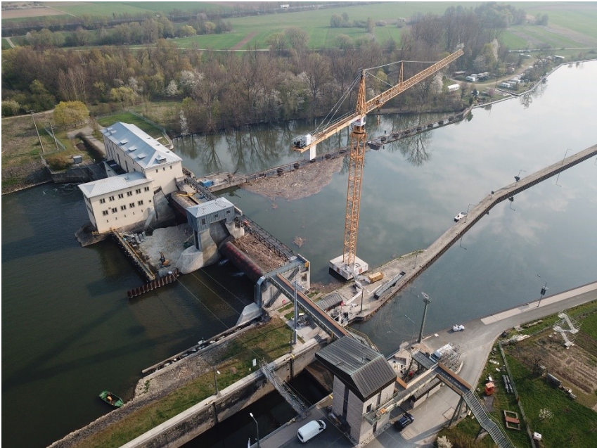
Abbildung 1: Luftbild der Wehranlage Viereth (Quelle: WSA Schweinfurt)
