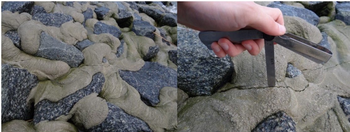
Abbildung 3: Risse des Typs 2 (Fotos: Kreyenschulte 2015).
