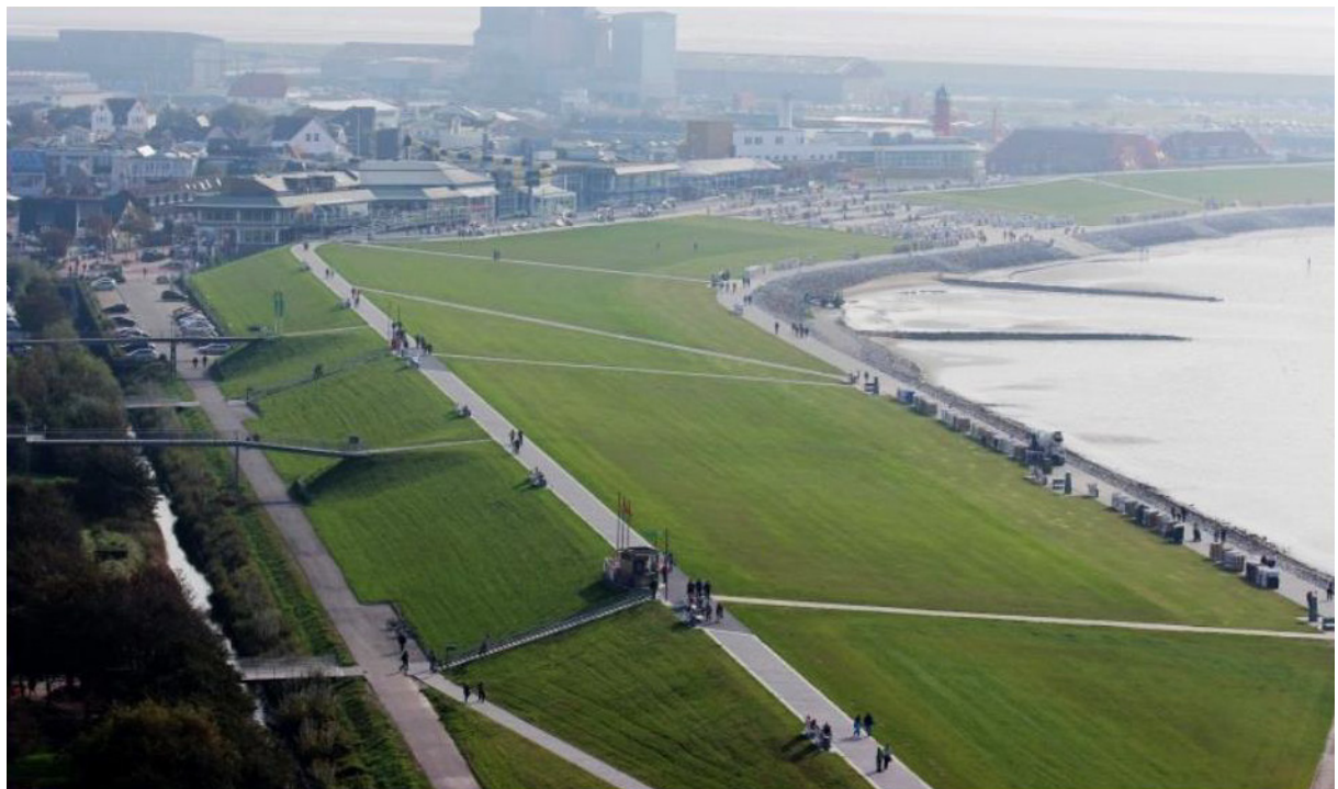
Abbildung 8: Landesschutzdeich in Büsum nach der Verstärkung (© LKN.SH).
