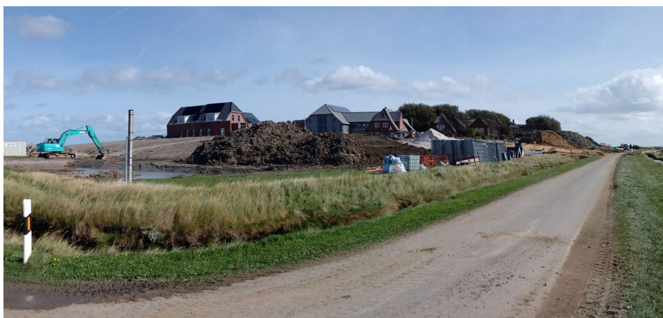
Abbildung 11: Plateauverstärkung an der Westseite von der Hanswarft (Hooge; © Hofstede)
