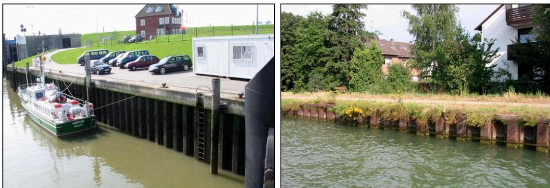
*Bild A5-1: Spundwände in Häfen und an Wasserstraßen*
