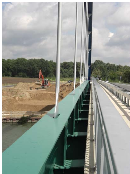
Bild 1: Geschmiedete Hängeranschlüsse / Hünxer Brücke, Wesel-Datteln-Kanal
