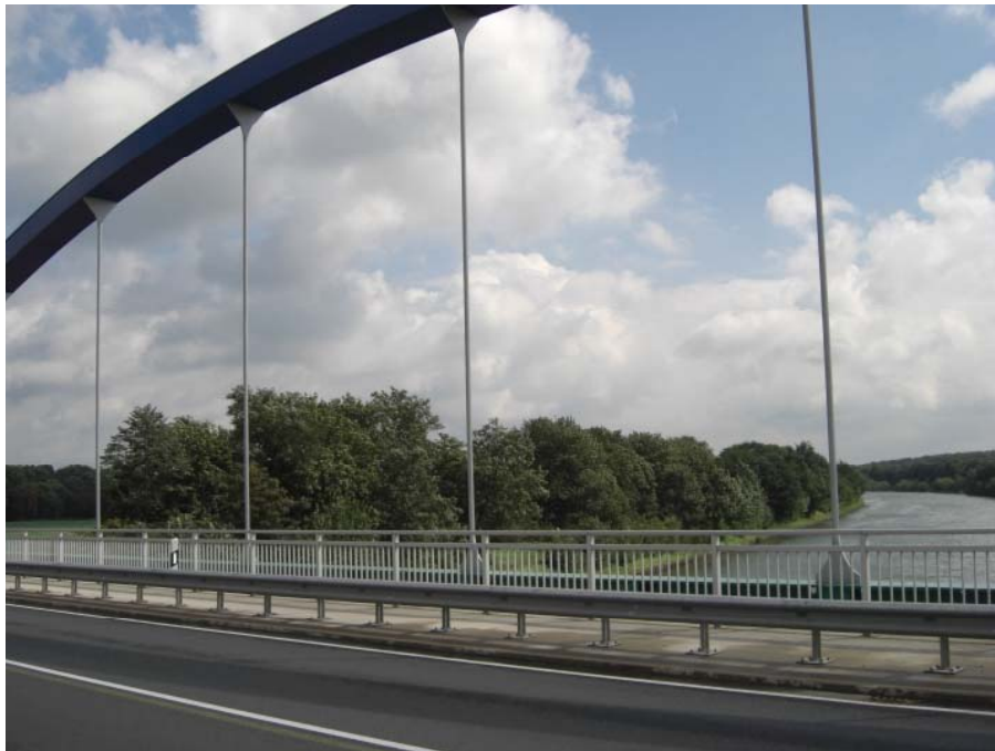
Bild 2: Hünxer Brücke, Wesel-Datteln-Kanal
