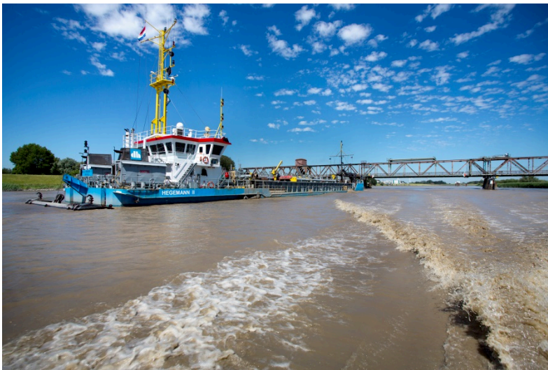
Bild 1: Baggerschiff auf der Unterems.
