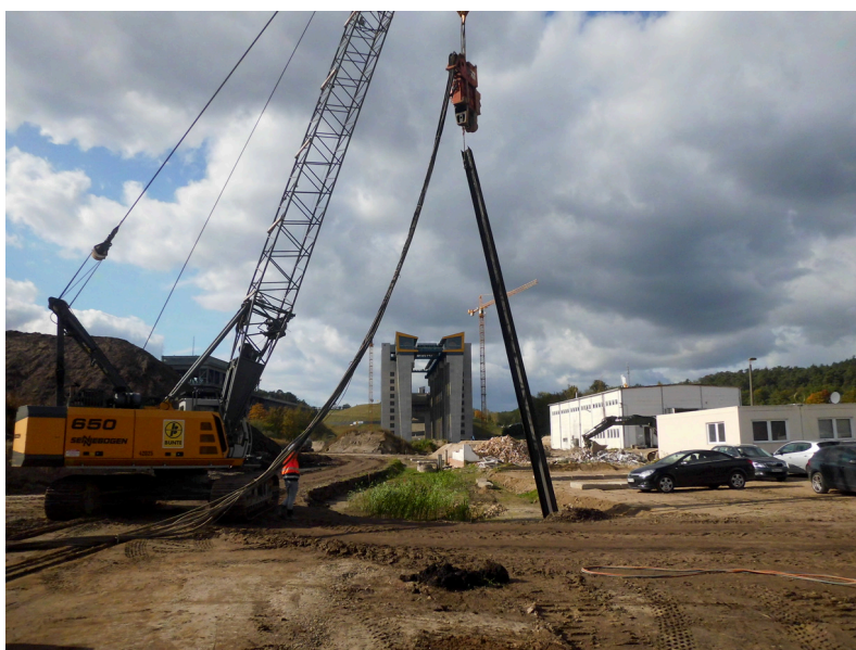
Bild 1: Ausgerüttelter Probepfahl.
