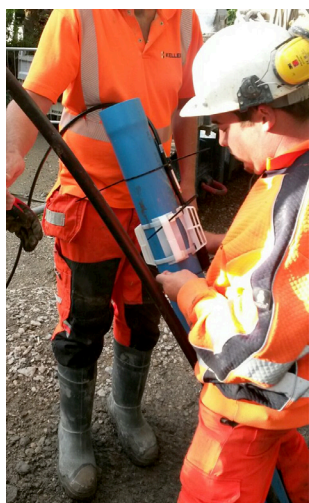
Bild 1: Einbau der Messkette in die Porenwasserdruckmessstelle.
