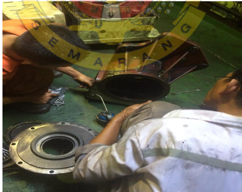
Gambar penggantian mechanical seal pada turning gea
