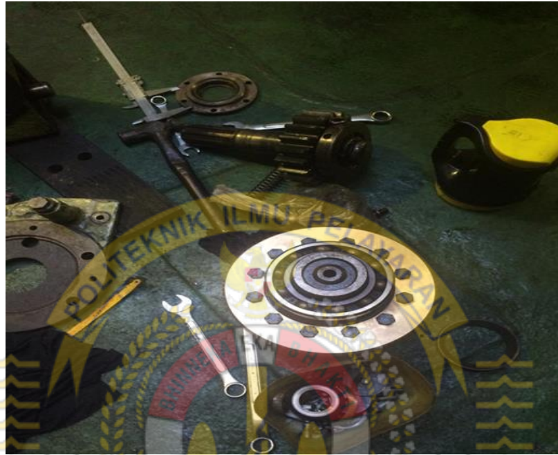
Gambar penggantian gear pada turning gear
