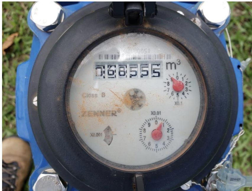
Figura 4.6 Display do hidrômetro taquimétrico WS2000.
