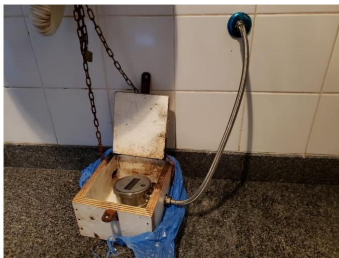
Figura 4.4 Instalação do manômetro no banheiro B1-633/62.
