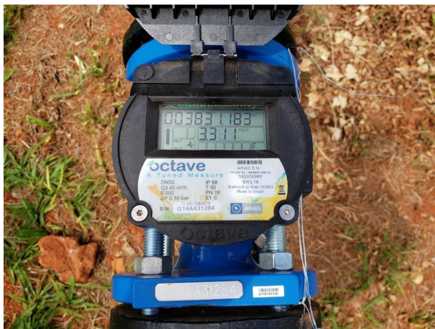
Figura 4.7 Display do hidrômetro ultrassônico Octave.
