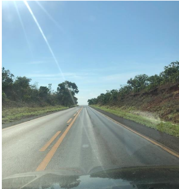
Figura 2.10 – Afundamento de trilha de roda (ATR) (BR 251/MG - Foto da autora).
