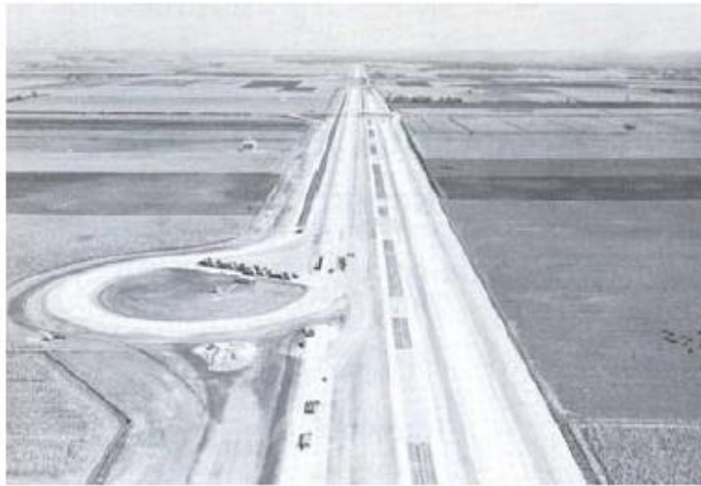
Figura 2.5 – Pista de teste AASHTO (Coutinho, 2011).
