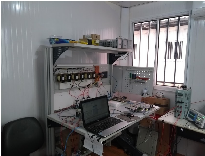
Figura 41 – Bancada do inversor trifásico com seus componentes
