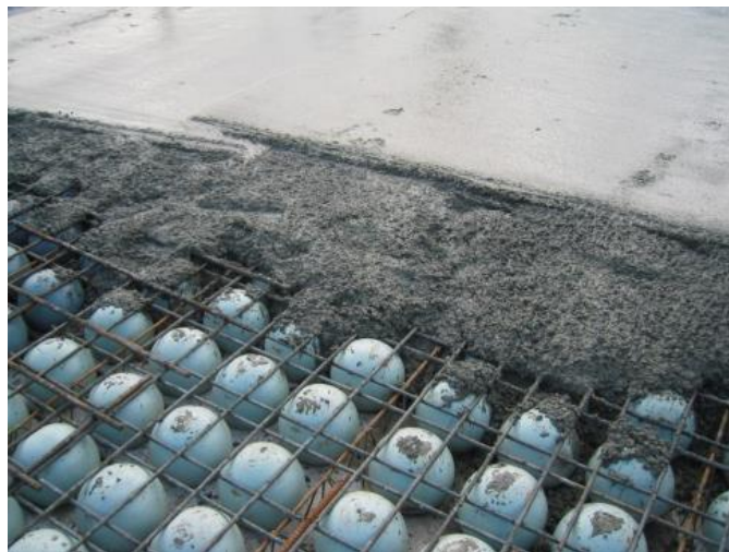
Figura 2-14: Concretagem Laje BubbleDeck no Centro Administrativo do DF (CA DF, 2014).
