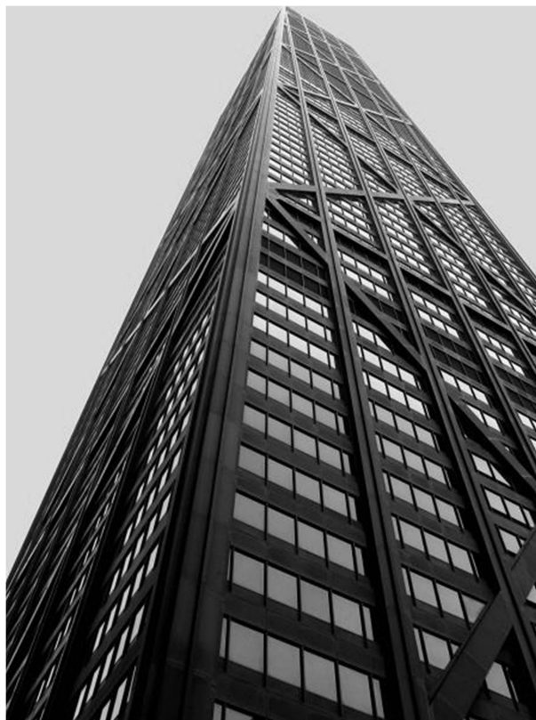
Figura 8 – John Hancock Building – Chicago, Estados Unidos
