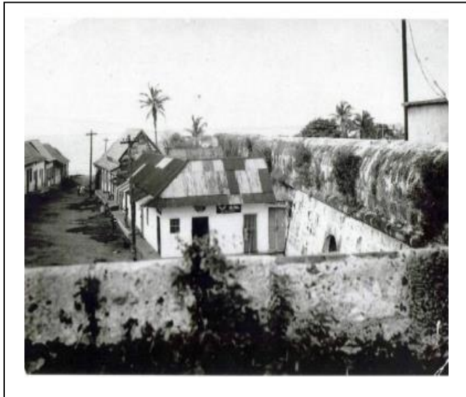
Foto 3. Barrio Pekín, adosado al baluarte de Santo Domingo en 1930.
