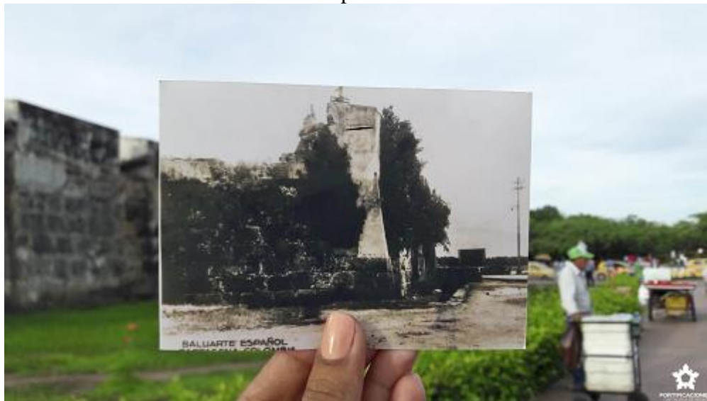
Foto 1. Baluarte San Pedro Mártir después de demolición de metros de muralla.
