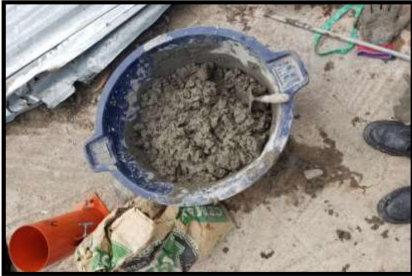
**Figura N° 9.** Mezcla de cemento Sol Portland tipo I, con agregado grueso y fino y agua.
