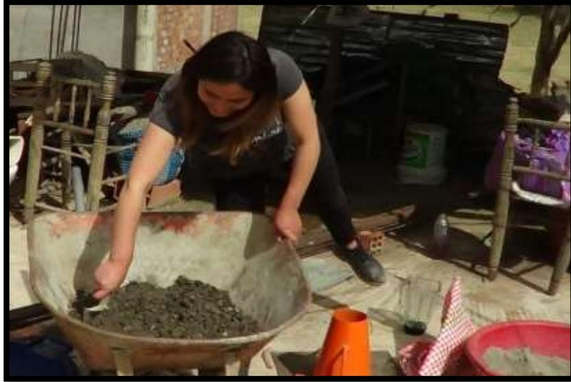
**Figura N° 10.** Mezcla de cemento Quisqueya Portland tipo I, con agregado grueso y fino y agua.
