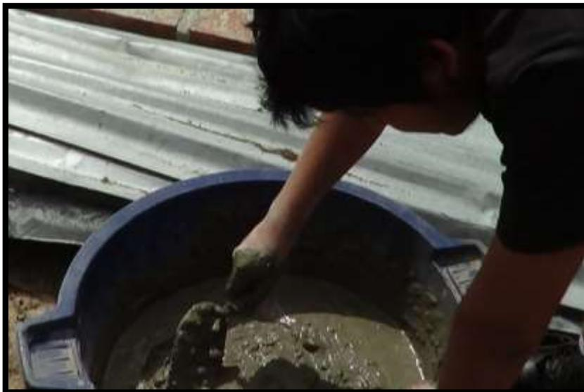
**Figura N° 16.** Homogenización de la muestra contenida con Cemento Sol Portland tipo I.
