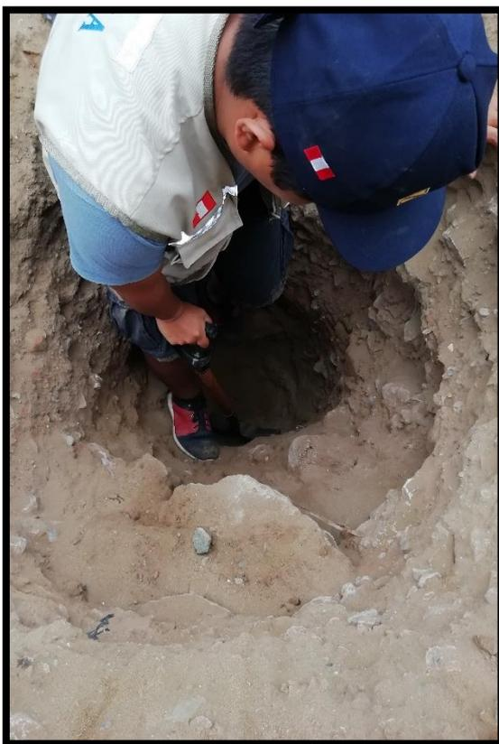
**ANEXO 5: Fotografía de excavación de calicatas a cielo abierto.**
