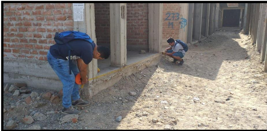
**ANEXO 4: Fotografía de levantamiento Topográfico con el Proceso de Winchado para obtener las Áreas de Puestos Comerciales.**
