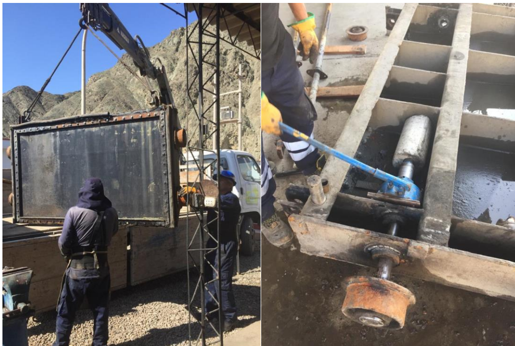
Figura 54. Retiro y mantenimiento de una de las compuertas hidráulicas.
