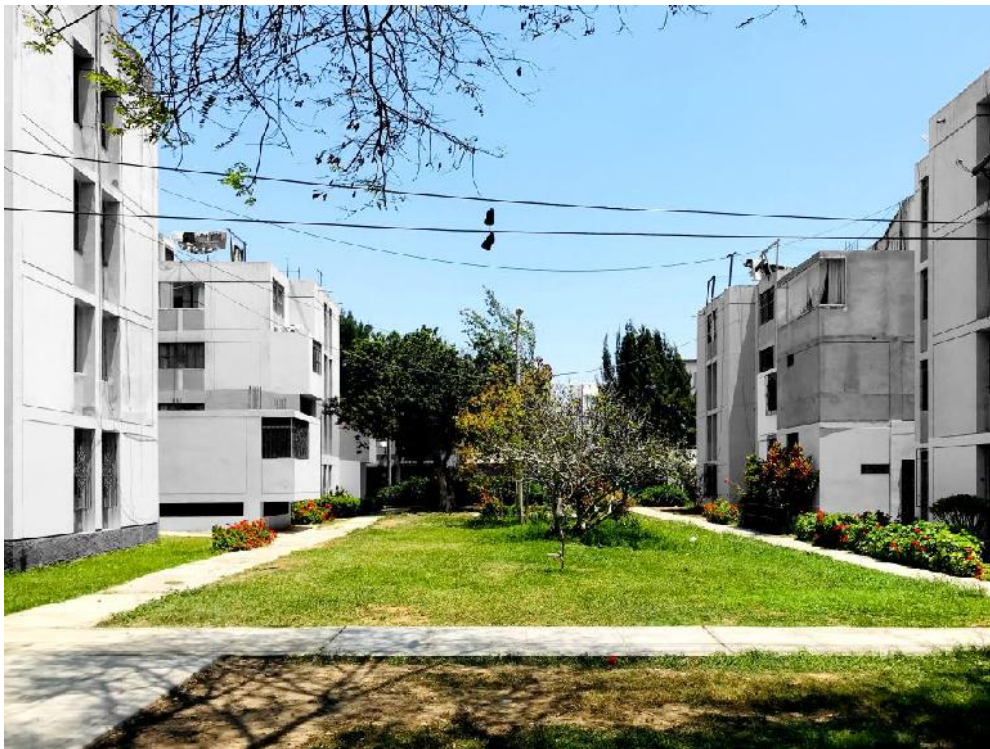
Ilustración 8 Superficie verde compuesta entre unidades multifamiliares
