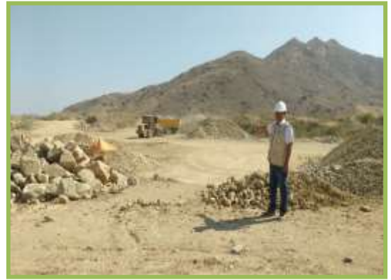
Extracción de materiales
