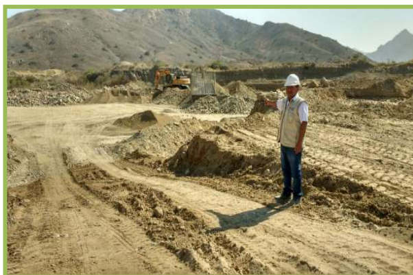
Extracción de materiales
