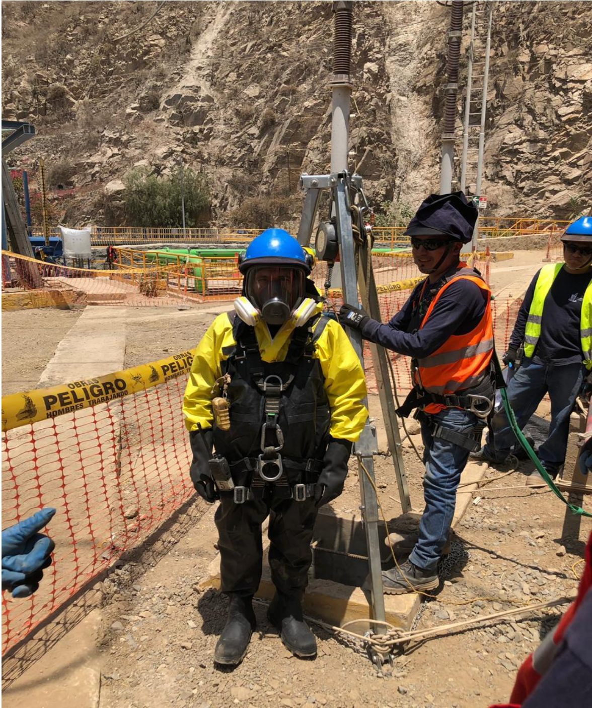
Foto 5. trabajador utilizando el sistema de protección contra caídas en la Central Callahuanca
