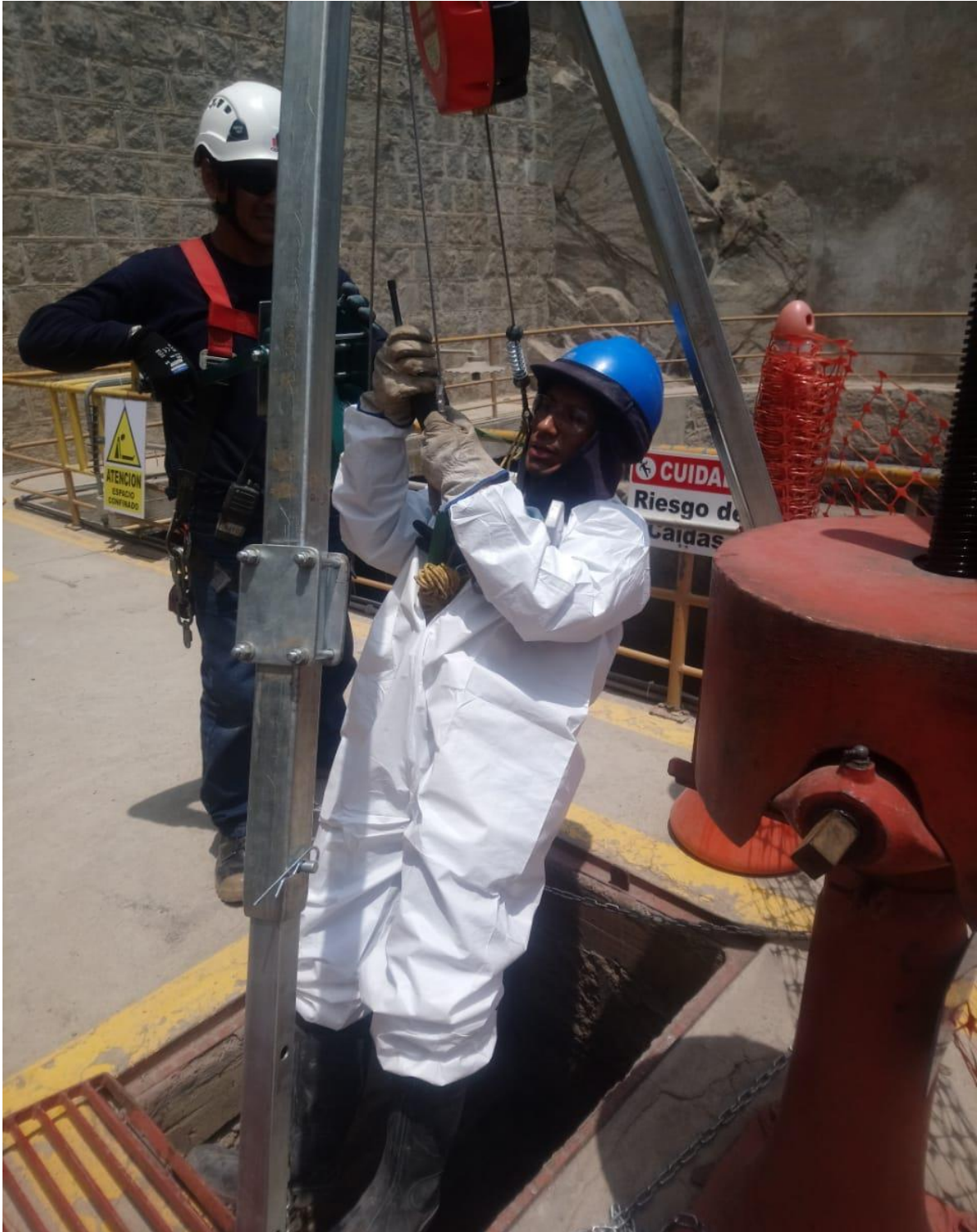
Foto 7. personal descendiendo mediante el SPCC
