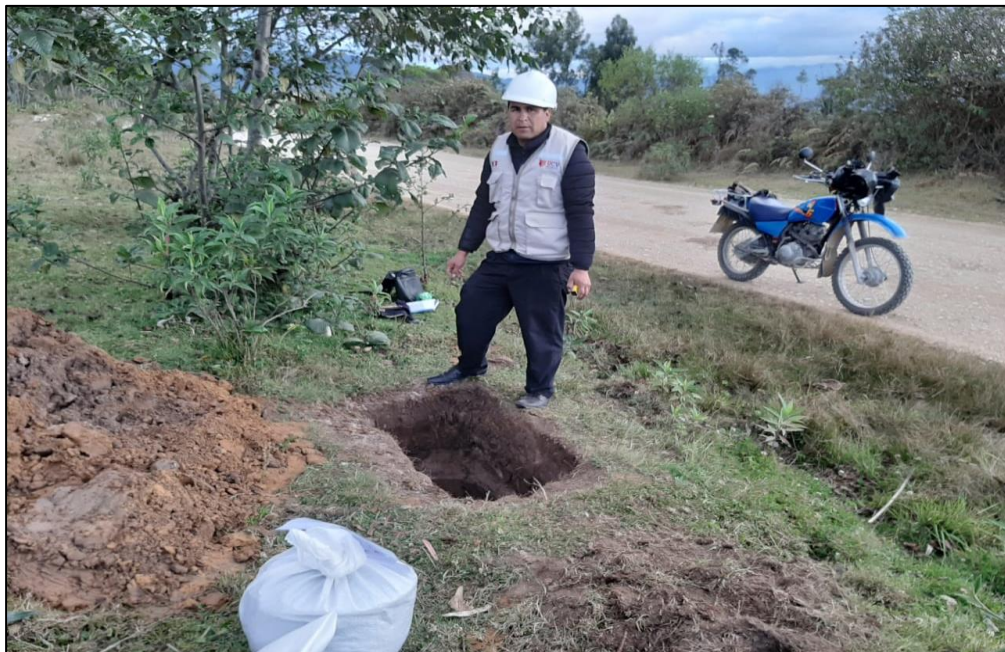
Figura 30. Calicata para toma de muestra.
