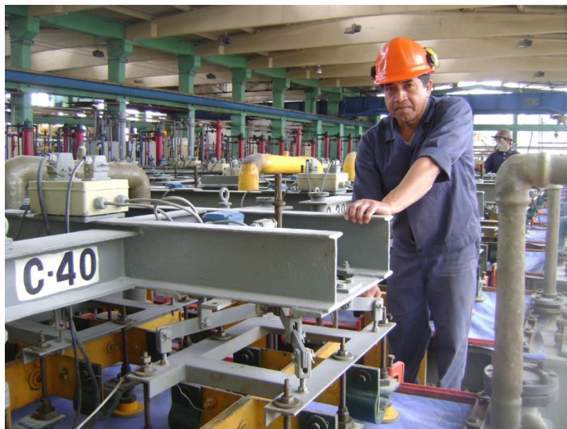
Figura 45. Mecánico realizando mantenimiento
