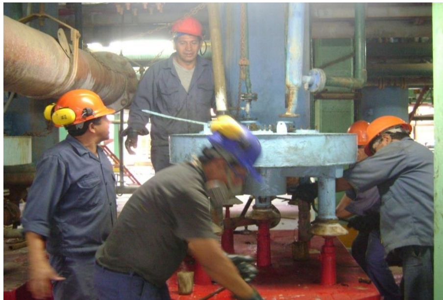
Figura 42. Los mecánicos ejecutando el mantenimiento de bomba
