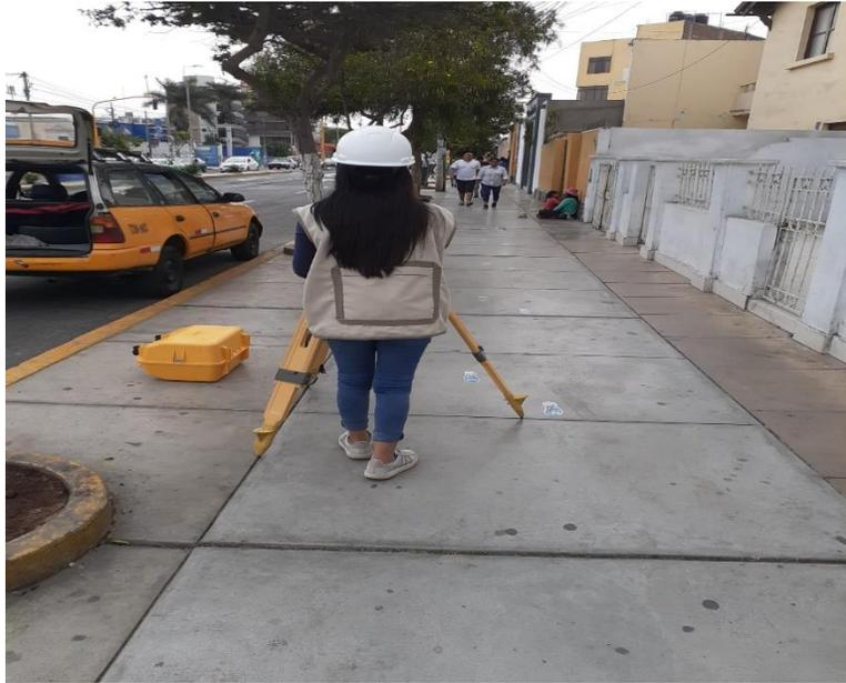
Figura 36 Levantamiento topográfico del centro histórico.
