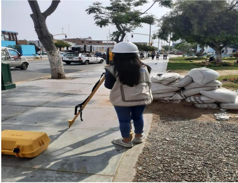
Figura 50 Levantamiento topográfico del centro histórico.
