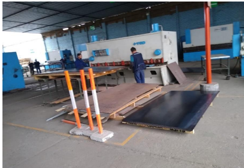
Figura 14. Planchas Ubicadas correctamente
