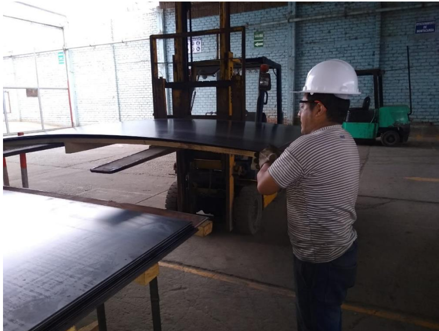
Figura 12. Colocación de Plancha
