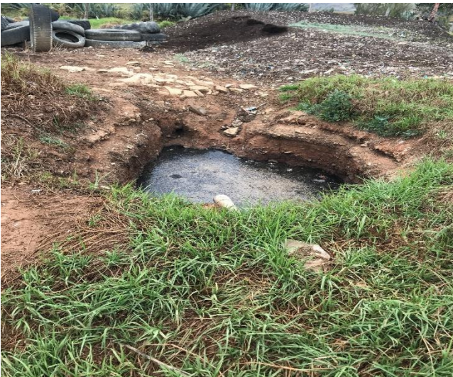
Figura 60. Filtración de Residuos
