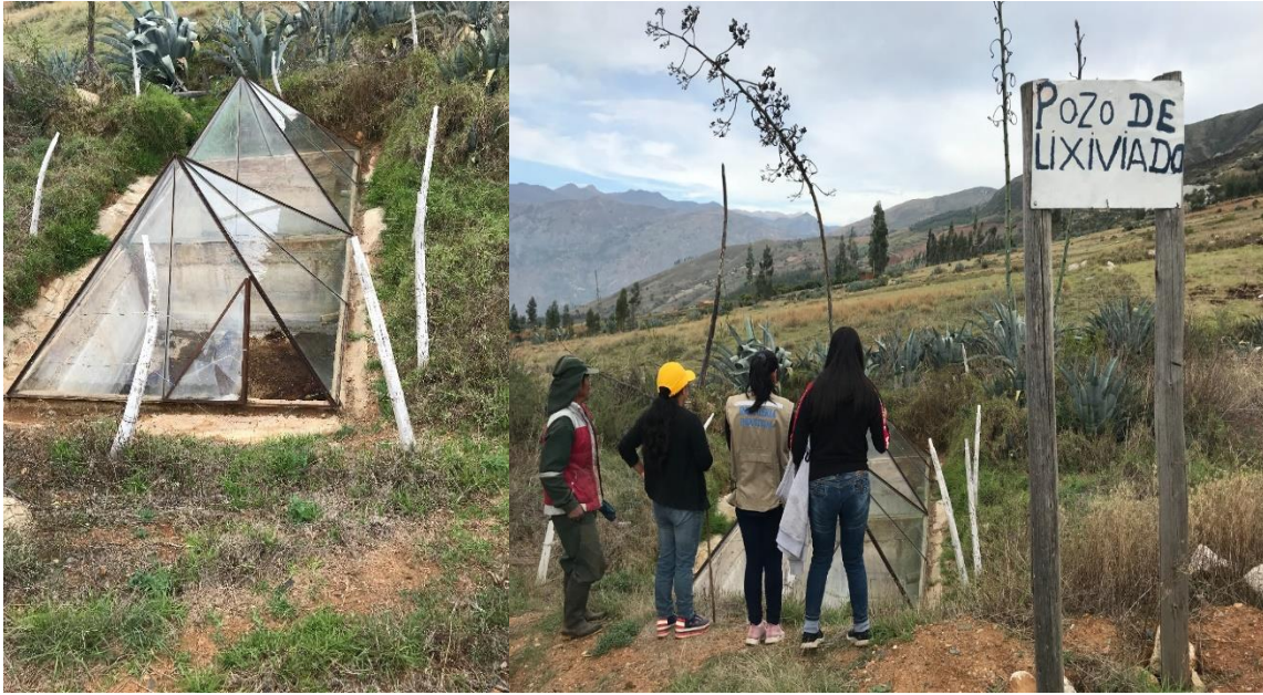
Figura 57. Pozo de Lixiviado
