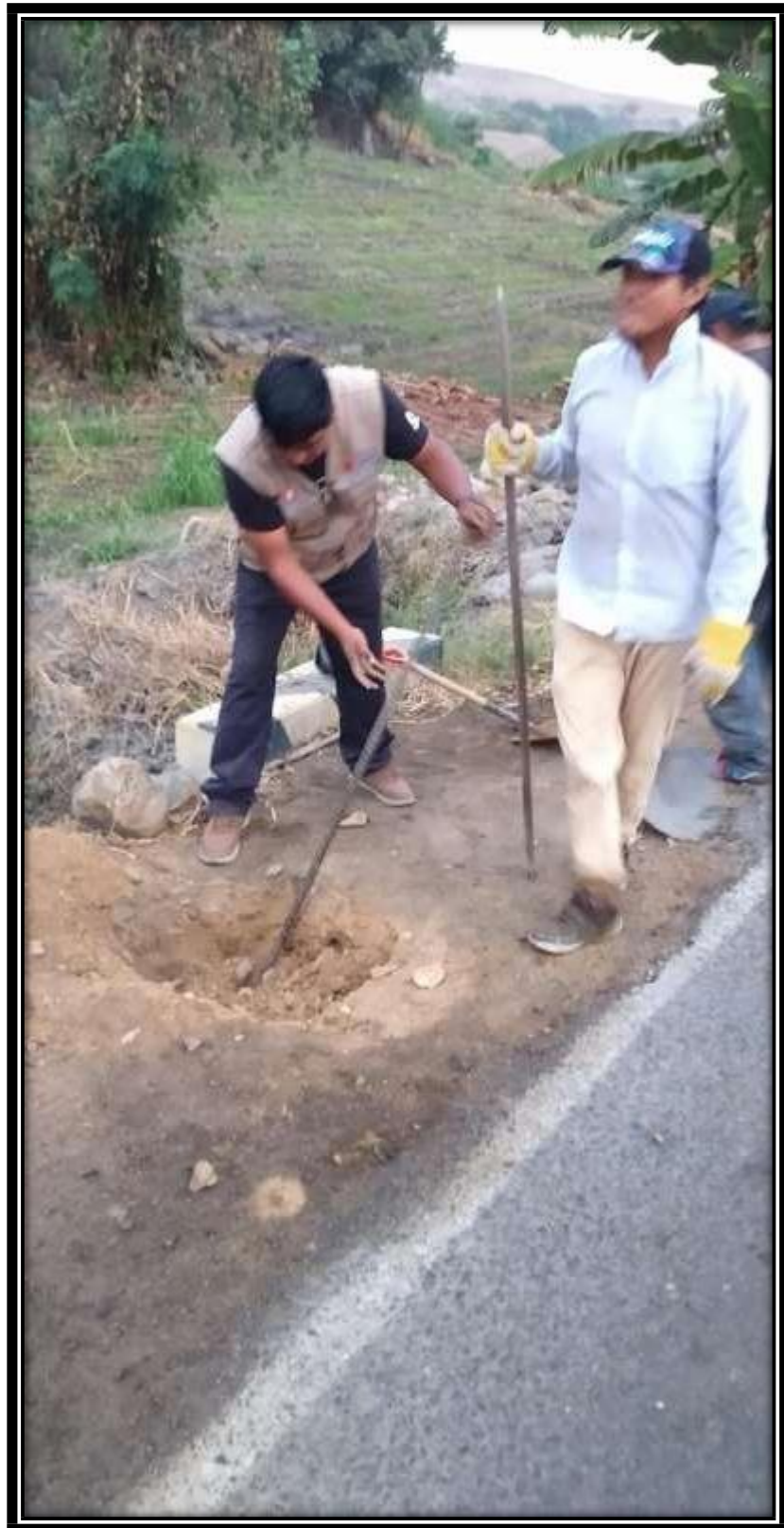
Fotografía N° 06: Excavación de pozos
